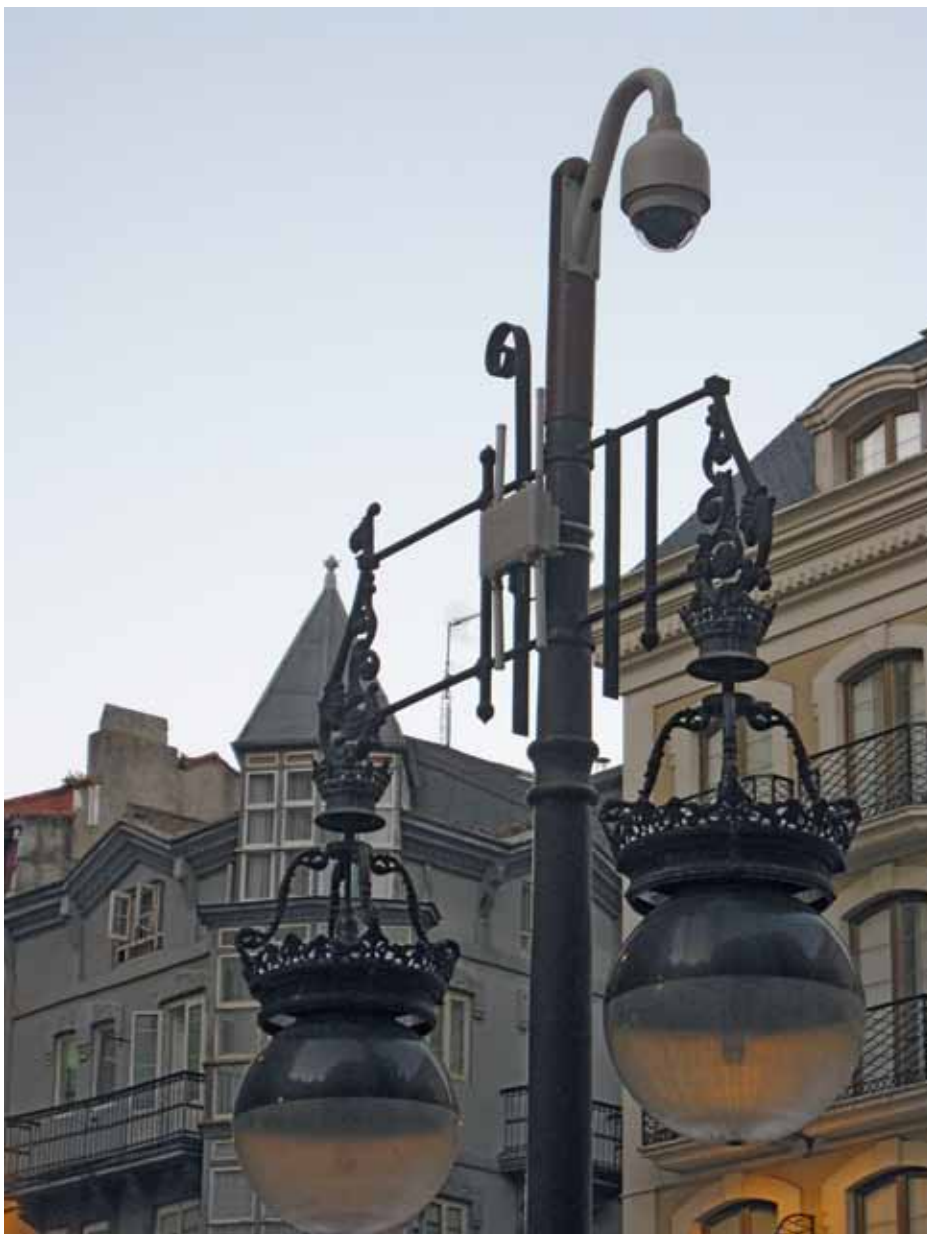
I starten var boksen til sensorerne meget lille, men den blev hurtigt gjort mere robust for at overleve vind og vejr.
