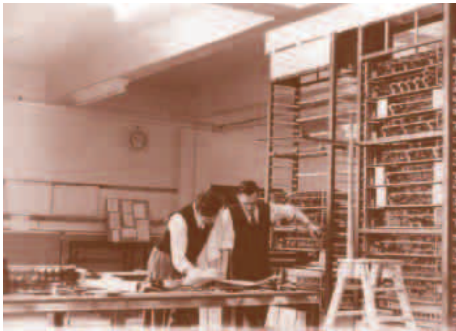
LEO, der her er ved at blive bygget, var baseret på Cambridges videnskabelige computer EDSAC, men med større fokus på håndtering af data-input og -output.
