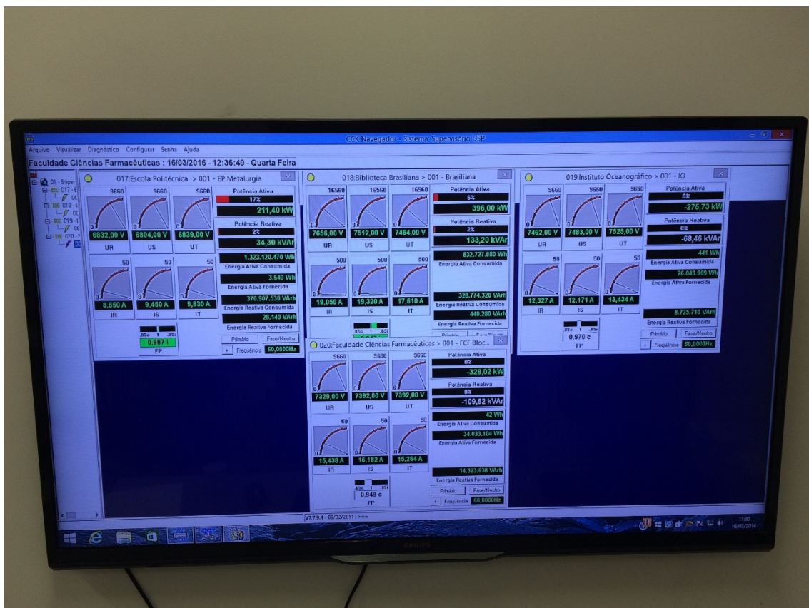
Figura 9: Tela de monitoramento de energia elétrica dos medidores (Eng. Leonardo Favato - PUERHE-USP)
