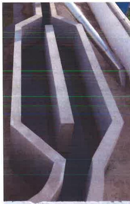
Figura 4 – Representação esquemática de uma caixa de areia.
