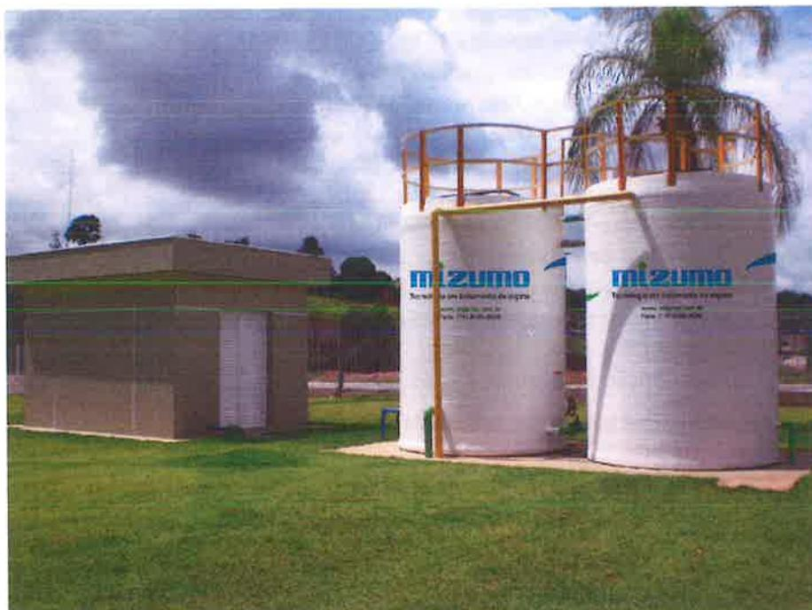
**Figura 1 - ETE Mizumo modelo Tower instalada**
