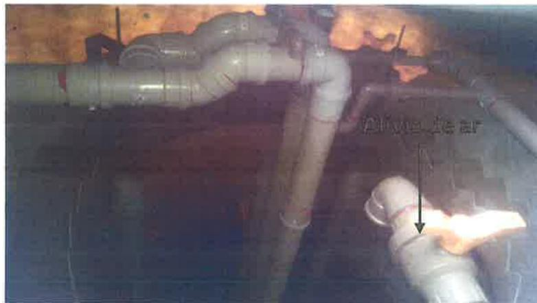
**Figura 21 – Detalhe representativo do alívio de ar da etapa aeróbia (FAS).**
