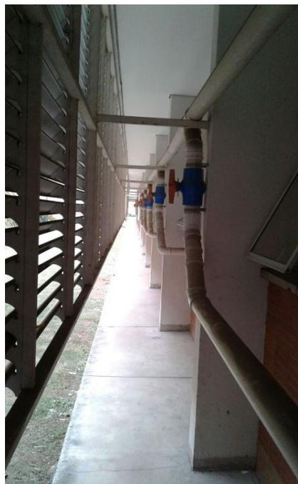
**Foto 4:** Sistema de ventilação - tubulações de captação de ar – Edifício Módulo Inicial.
