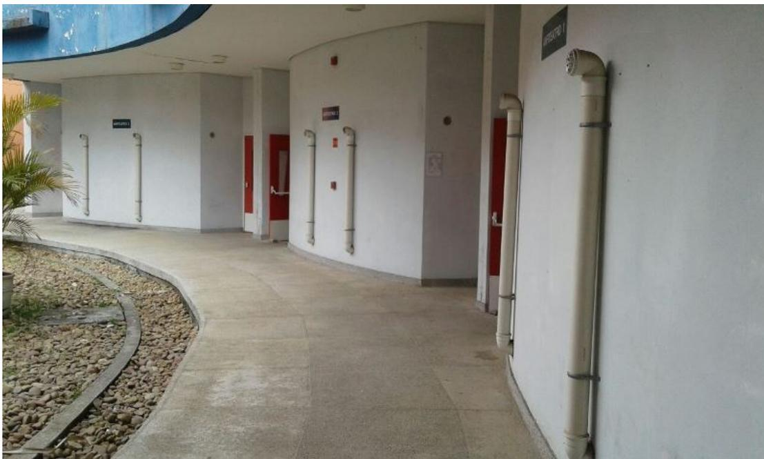
**Foto 2:** Vista das tubulações e captações dos sistemas de ventilação instalados nos Anfiteatros (Edifício Módulo Inicial).
