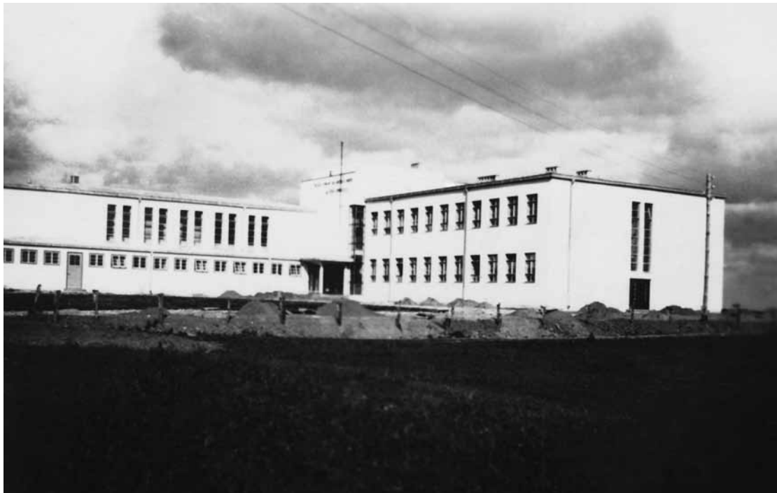
Telšių valstybinės vyskupo Motiejaus Valančiaus gimnazijos pastato statybos baigiamieji darbai. 1936 m. Fot. nežinomas. Žemaičių muziejus „Alka“, ŽAM GEK 37027/1
