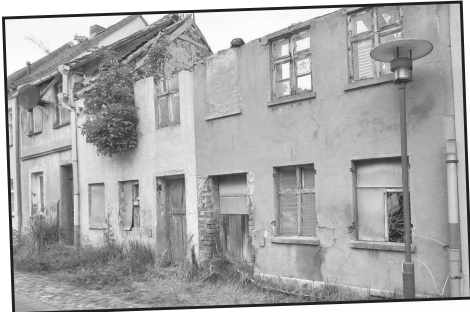
Reparaturen am Haus
