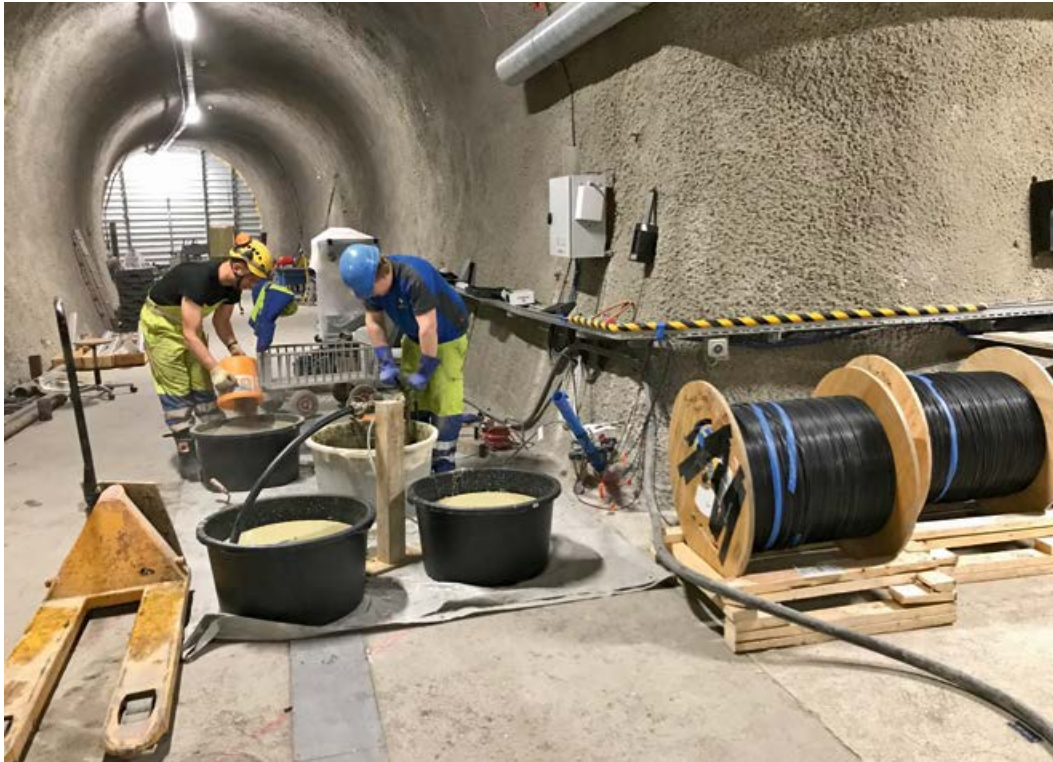
Abbildung 23: Zementation des Ringraums einer Bohrung und Einbau faseroptischer Messkabel (Photo: M. Robertson, LBNL).
