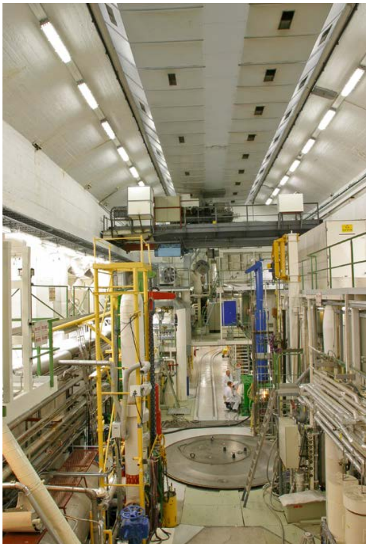
Abbildung 1: Blick in die Halle des Halden-Reaktors. Der Siedewasserreaktor mit einer maximalen thermischen Leistung von 20 Megawatt befindet sich in einer Felskaverne. Quelle: HRP.
