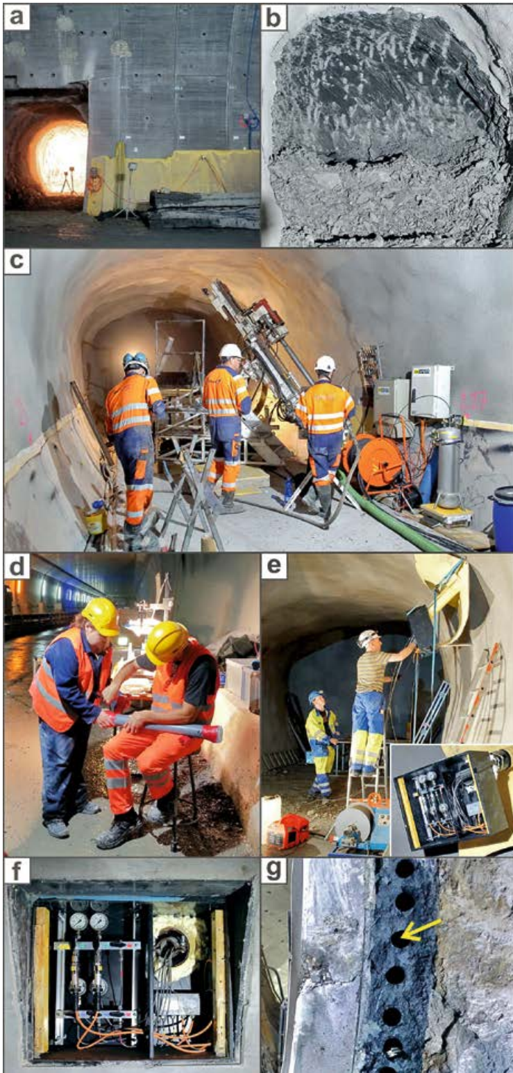
Abbildung 36: (a) Querverbindung 5a, ca. 8 bis 9 m nördlich des Messquerschnitts bei Tunnelmeter 2317 (Abb. 1, Abb. 2), (b) Ungesicherte Ortsbrust der Querverbindung 5a, (c) Bohrarbeiten für die Bohrung CP-2 (Abb. 4) und Einrichtungen für hydraulische Tests, (d) Bohrlochversiegelung kurz nach den Bohrarbeiten, (e) Installation des Doppelpackersystems für Porenwasserdruck-Messungen in der Bohrung CP-4 (Abb. 4), Installation des Systems für Datenerfassung und Kontrolle von hydraulischen Messungen, (f) Installierte Messeinrichtungen in der Ort beton-Innenschale, und (g) Kurze Bohrung (<1 m, gelber Pfeil) für die Entnahme von Proben des Ringspaltmörtels. Quelle: Forschungsbericht ETH Zürich 2017 (Anhang A).
