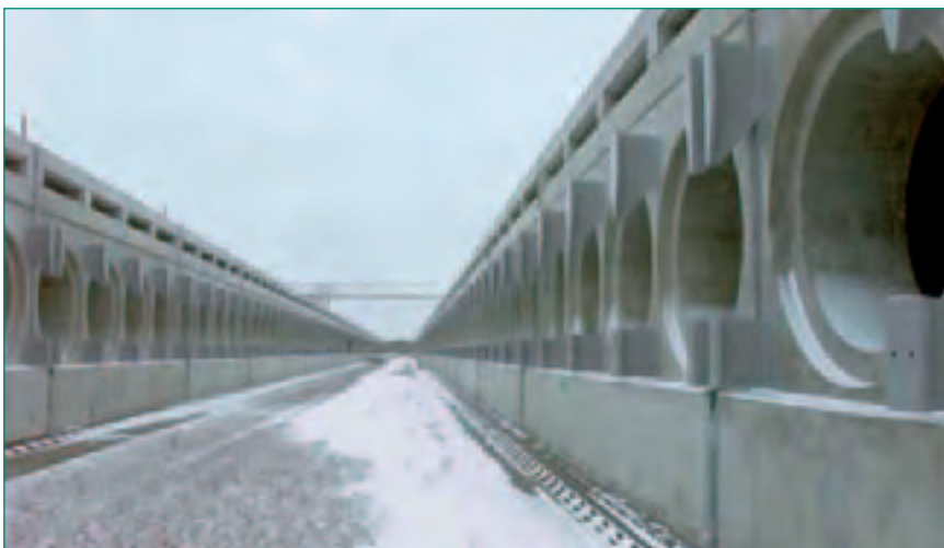
Figur 4: Blick auf die Rohbauten der Interim Spent Fuel Storage Facility 2 des stillgelegten Kernkraftwerks Tschernobyl.
