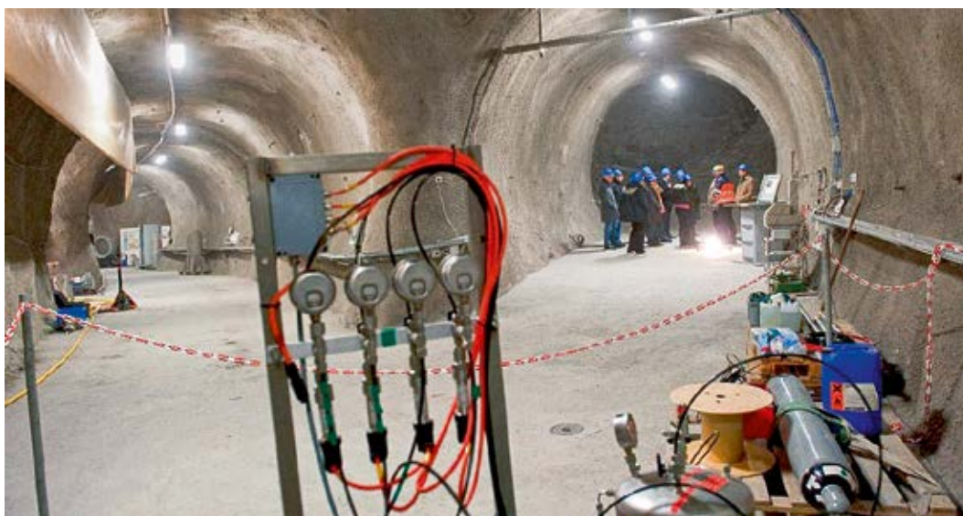
Abbildung 29: Verzweigung im Tunnel-system des Felslabors Mont Terri, im Hintergrund rechts mit Besuchergruppe anlässlich einer der zahlreichen Führungen. Quelle: www.mont-terri.ch , heruntergeladen am 13.12.2017
