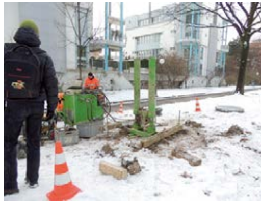
Abbildung 14: Durchführung eines Cone Penetration Tests (Drucksondierung). Quelle: SED
