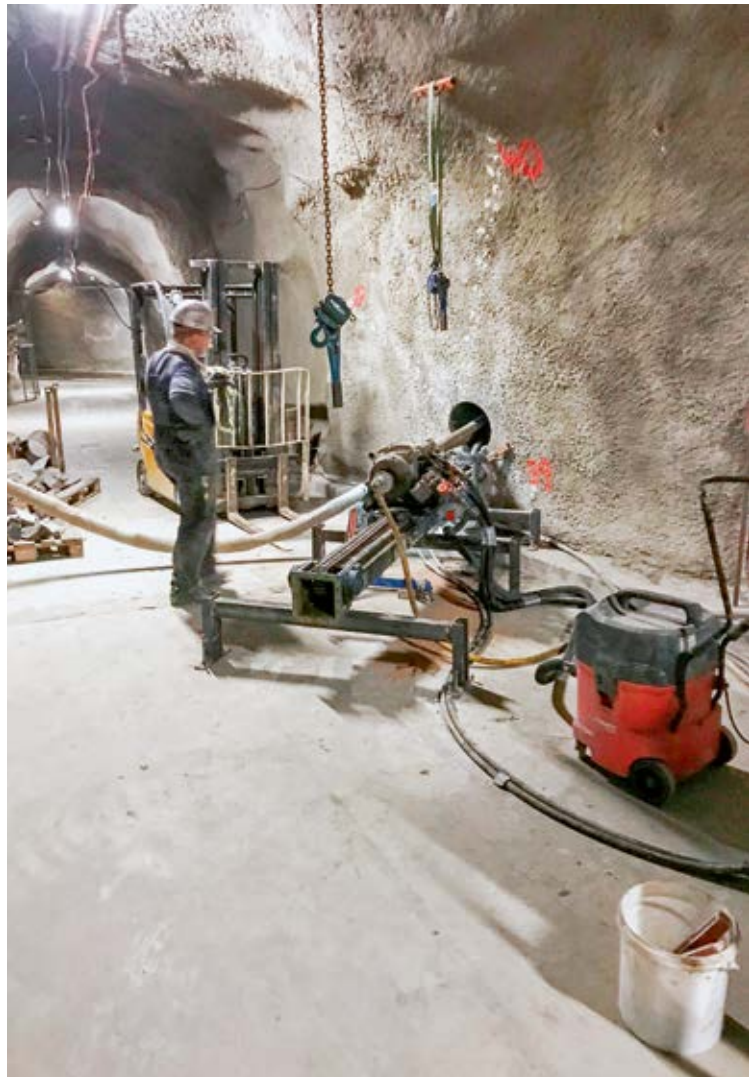
Abbildung 31: Überbohren der Pilotbohrung im Felslabor Mont Terri, Galerie 98, November 2017. Quelle: ENSI
