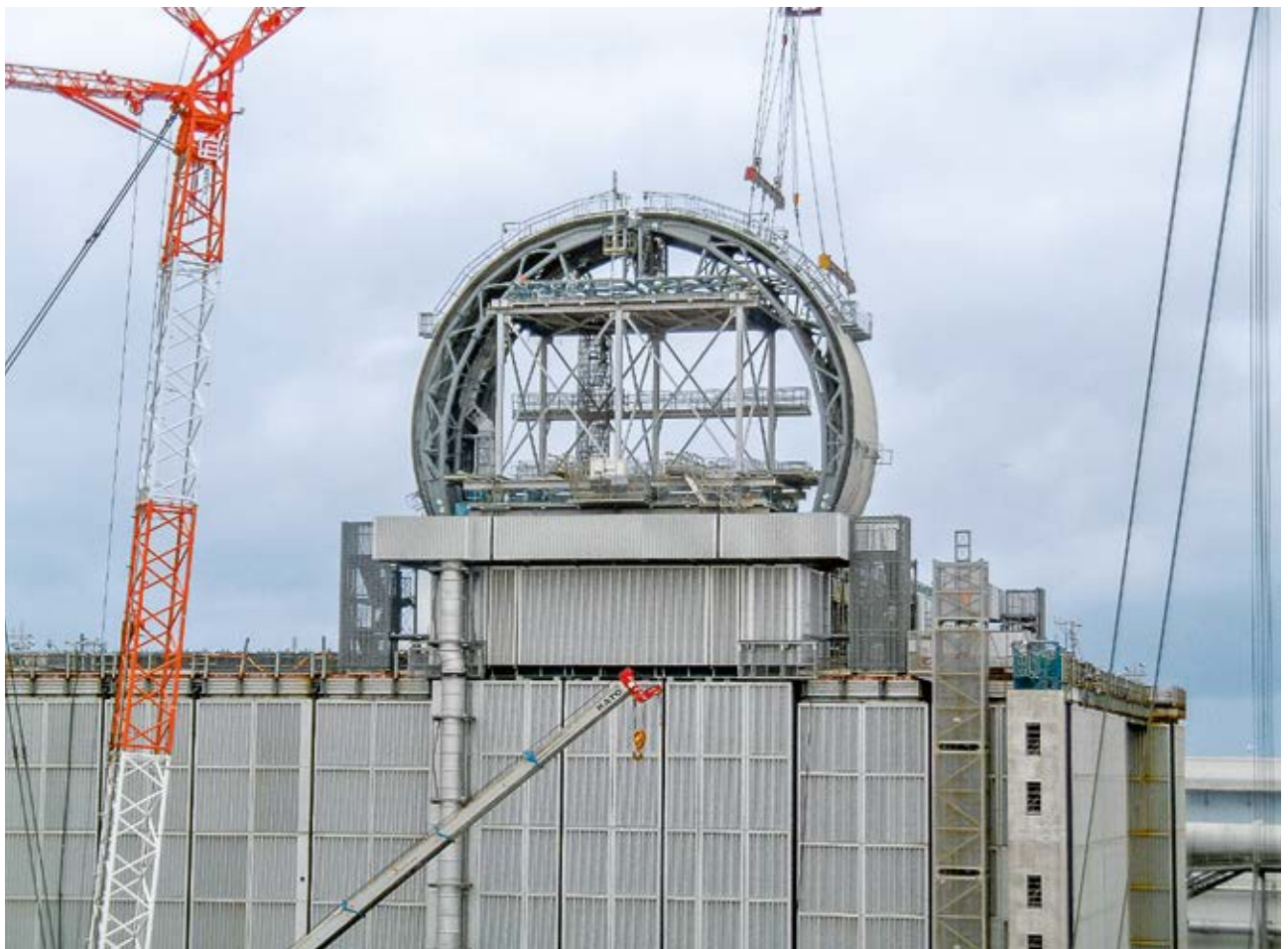
Abbildung 23: Bau des Schutzschildes über Block 3 für den Abtransport der abgebrannten Brennelemente aus dem Brennelementbecken, Quelle: http://photo.tepco.co.jp/library/170802_01/170802_03.jpg .
