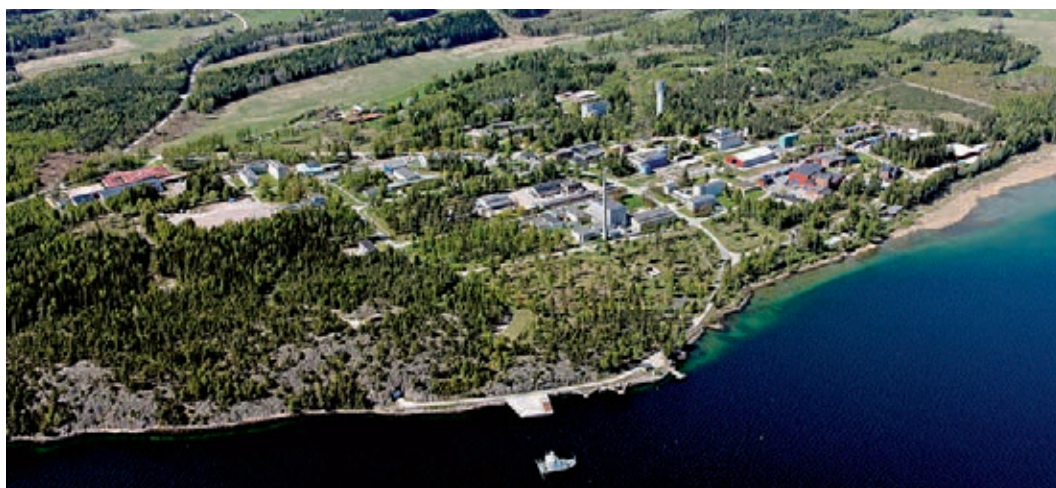
Abbildung 2: Forschungsstandort der Firma Studsvik an der schwedischen Ostküste südlich von Stockholm. Quelle: Studsvik.
