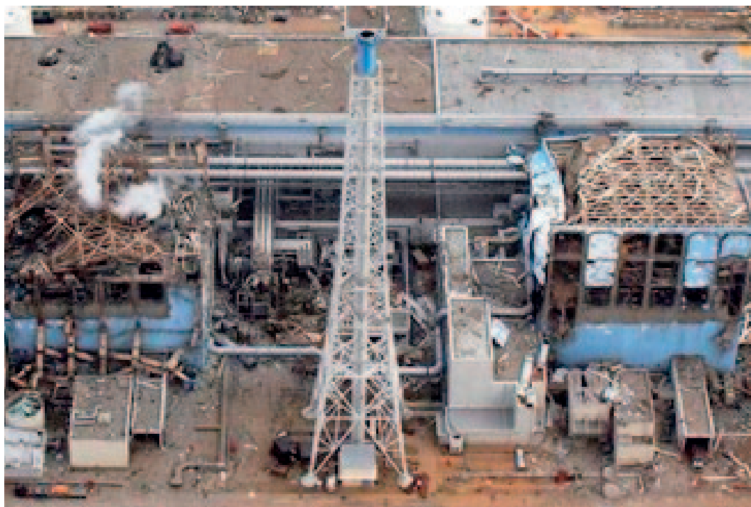
Figure 14: Vue des tranches 3 et 4 après les explosions hydrogène (source: TEPCO).
