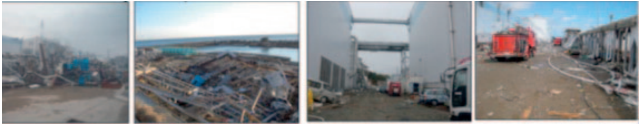
Figure 7: Dommages sur site à Fukushima Dai-ichi (source: TEPCO).
