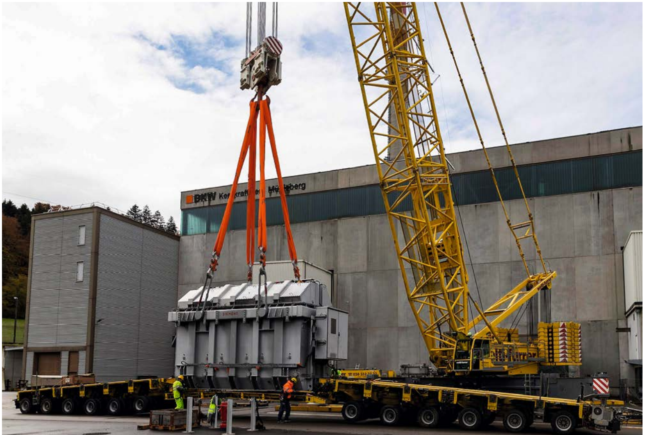
Ein Kran hebt einen der beiden Blocktransformatoren des Kernkraftwerks Mühleberg auf einen Tieflader. Bild: BKW
