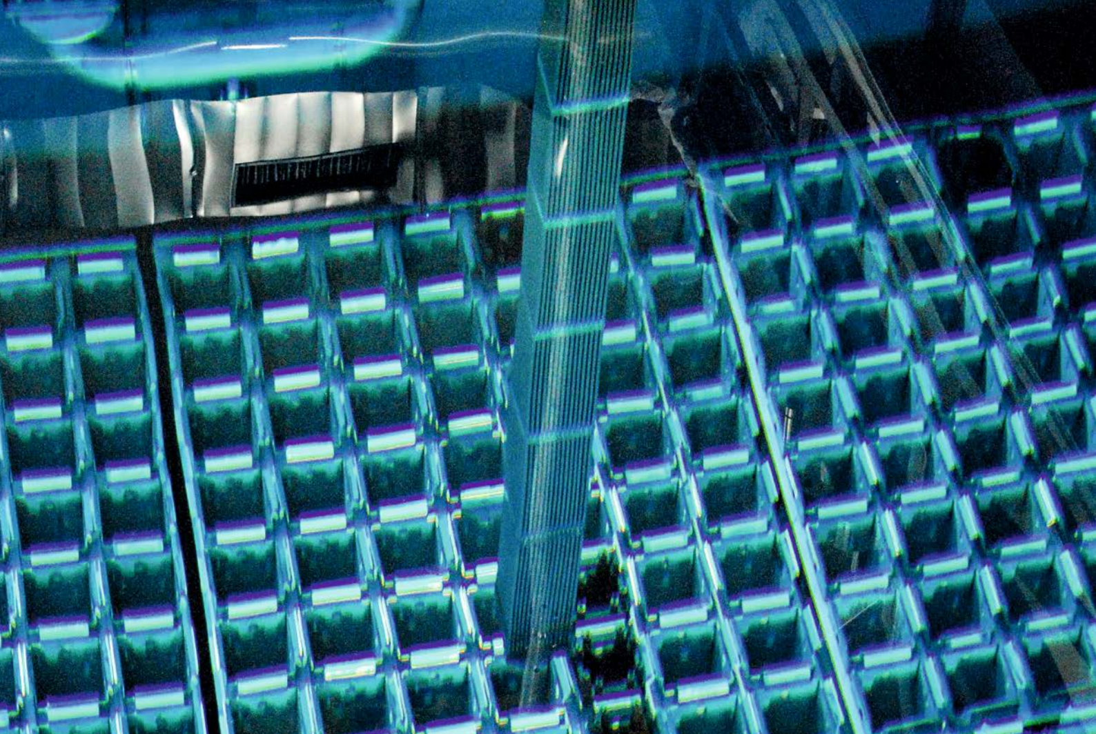
Nasslager abgebrannte Brennelemente im Kernkraftwerk Gösgen. Bild: KKG
