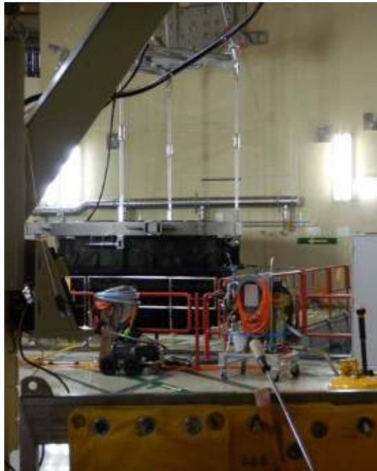
Bild 7: Lufttransport des oberen Kerngerüsts. Bei dieser Art des Transports wird das Kerngerüst aus dem Wasser gehoben, um auf die Abstellposition oder zurück transportiert zu werden.
