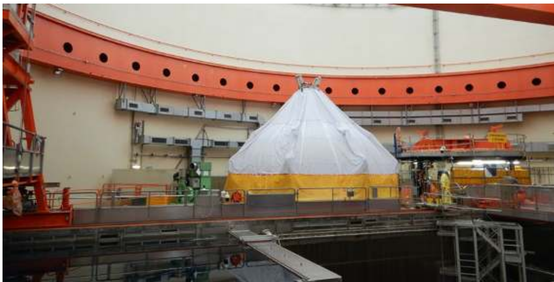
Bild 9: Zur Kontaminationsverhinderung abgedeckte Komponente während des Revisionsstillstandes.
