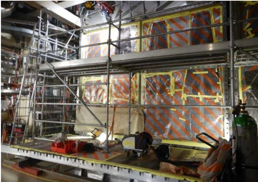
Bild 10: Arbeitsplatz für die auf- wändigen Arbeiten beim Ersatz des Haupt- kondensators.
