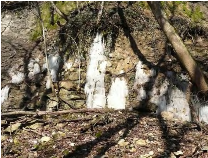
Abb. 2.26: Eisbildungen bei Wasseraustritten aus den Kalken/Sandkalken im Aufschluss Bernhardholz bei Kadelburg. Die Eisbildungen beschränken sich auf den unteren Teil der Wand. Das austretende Wasser versickert im Hangschutt und tritt tiefer am Hang in kleinen Quellen aus. Die Sandkalkbänke werden von mergeligen Formationen des mittleren Doggers überlagert. (Aufnahme Januar 2011, CH-Koord.: 665'730/273'700)
