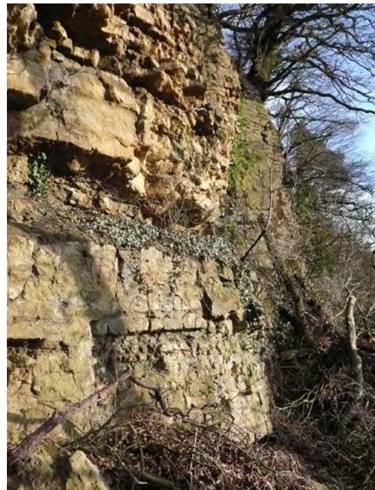
Abb. 2.7b: Kalk und Sandkalk am Blitzberg, E Klingnau. Die härteren Kalkbänke werden durch dünne, sandige Mergellagen getrennt. Die Klüftung ist intensiv. (Aufnahme Januar 2011, CH-Koord.: 661'780/270'400)
