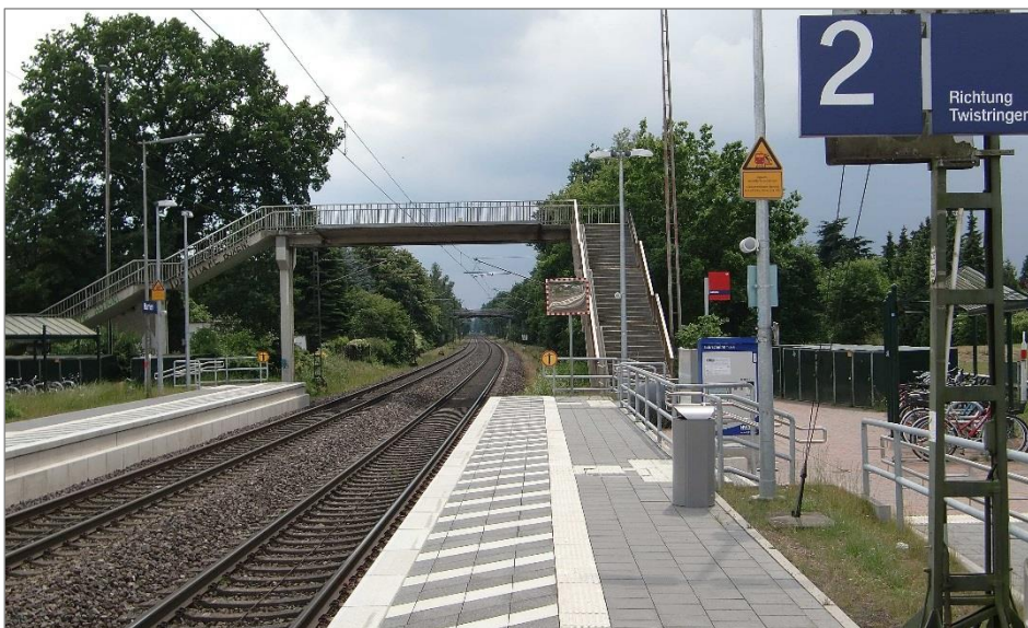
Abb. A-7: In Barrien wurden zwar die Bahnsteige grundhaft ausgebaut und erhöht, deren Erreichbarkeit aus dem Umfeld ist jedoch auch weiterhin nur über die Treppen der bestehenden Fußgängerbrücke möglich und damit eine stufenfreie Zugänglichkeit nicht gegeben. (Quelle: ZVBN)
