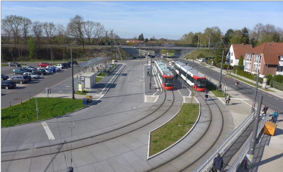
Abb. C-4: Gutes Beispiel: In Bremen-Mahndorf wurde nicht nur die Verkehrsstation verschoben, sondern durch Verlängerung der Straßenbahnlinie 1 bis unmittelbar an die Station heran sowie Anpassungen der Buslinienführungen eine direkte Verknüpfung zwischen dem SPNV und dem übrigen ÖPNV hergestellt. (Foto ZVBN)
