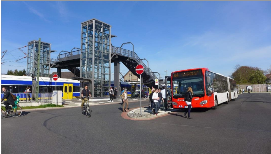
Abb. A-8: Optimale Bahn-Bus-Verknüpfung am runderneuertem Bahnhof Bremen-Mahndorf (Quelle: ZVBN)
