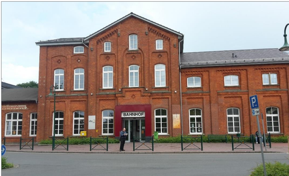
Abb. C-13: Gutes Beispiel: Das Bahnhofsgebäude von Bassum ist in den letzten Jahren in Regie der Stadt Bassum grundhaft saniert und modernisiert worden. Neben einem Reisebüro mit Fahrkartenverkauf, einem Backshop mit Lounge, Warteraum und Toiletten konnten auch öffentliche Einrichtungen wie Volkshochschule und Musikschule integriert werden, so dass die Wiederbelebung des historischen Gebäudes bestens gelungen ist. (Foto ZVBN)
