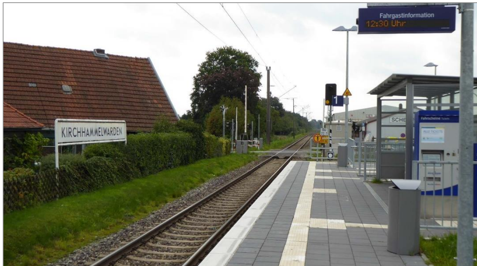
Abb. A- 4: An der Bahnstrecke Hude–Nordenham ist im Braker Ortsteil Kirchhammelwarden im Dezember 2014 ein neuer Bahnhaltepunkt in Betrieb gegangen. (Quelle: ZVBN)
