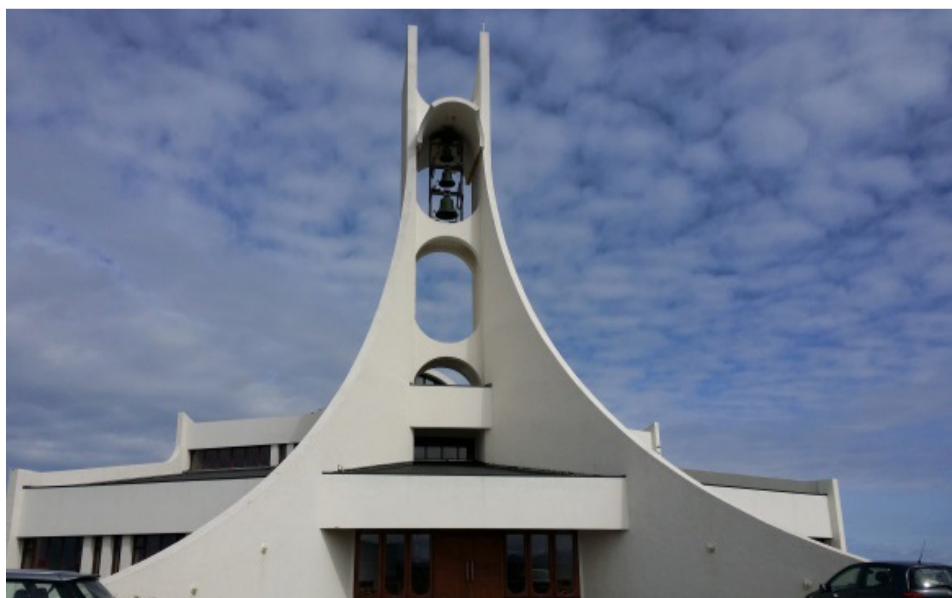
Verksýn hefur haft umsjón og eftirlit með viðhaldsframkvæmdum við Stykkishólmskirkju undanfarin 3 ár.
