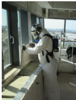
Undirþrýstingur myndaður með Hepa-blásurum sem hreinsa 99,997% af ögnum yfir 0,3 mikrómetra að stærð áður en dælt er út um glugga.
