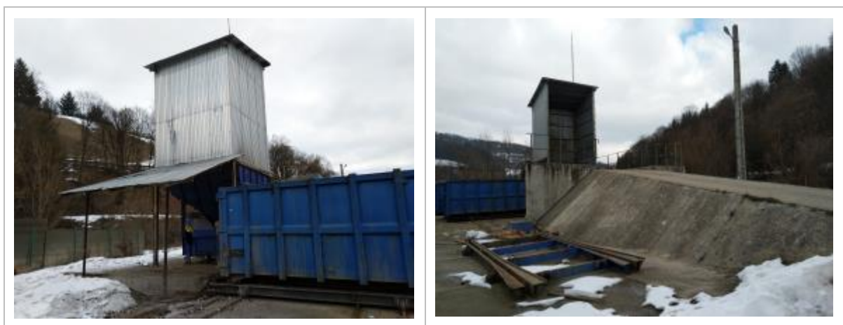
Figura 4 - 17: Stație de Transfer Abrud
