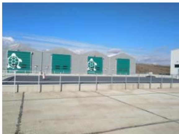
Stația TMB – tratare biologică
