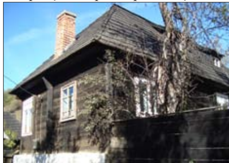
Acoperiș în 4 ape acoperit cu șindrila
