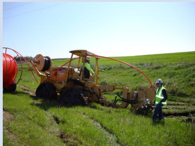
A Plow Installing Conduit
