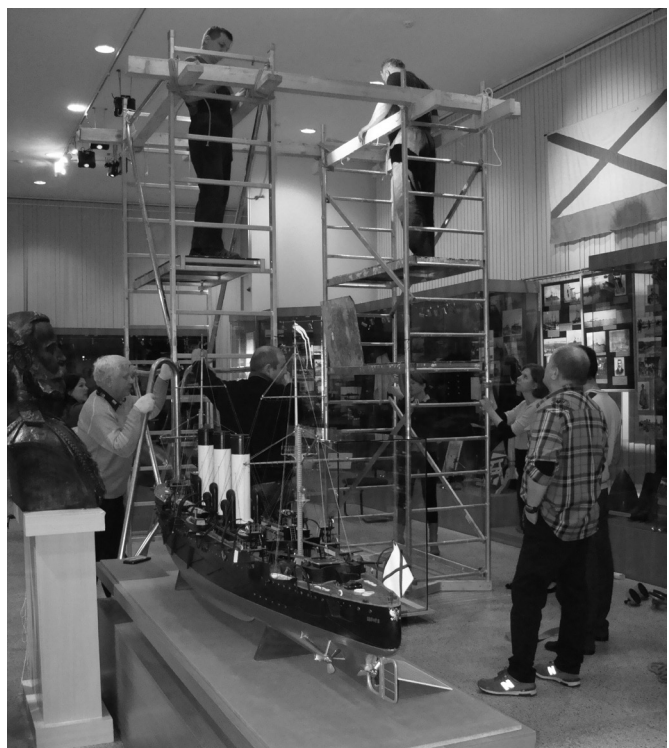
Рис. 7. Монтаж конструкции для установки защитного футляра в зале № 2 Центрального Музея Вооружённых Сил.
