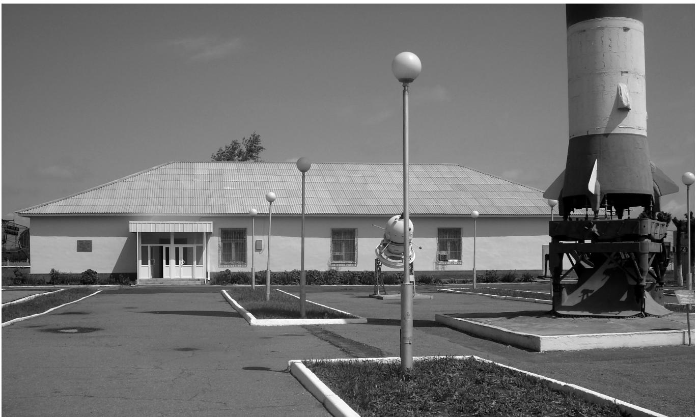
Рис. 3. Здание филиала Музея РВСН в г. Знаменск.
