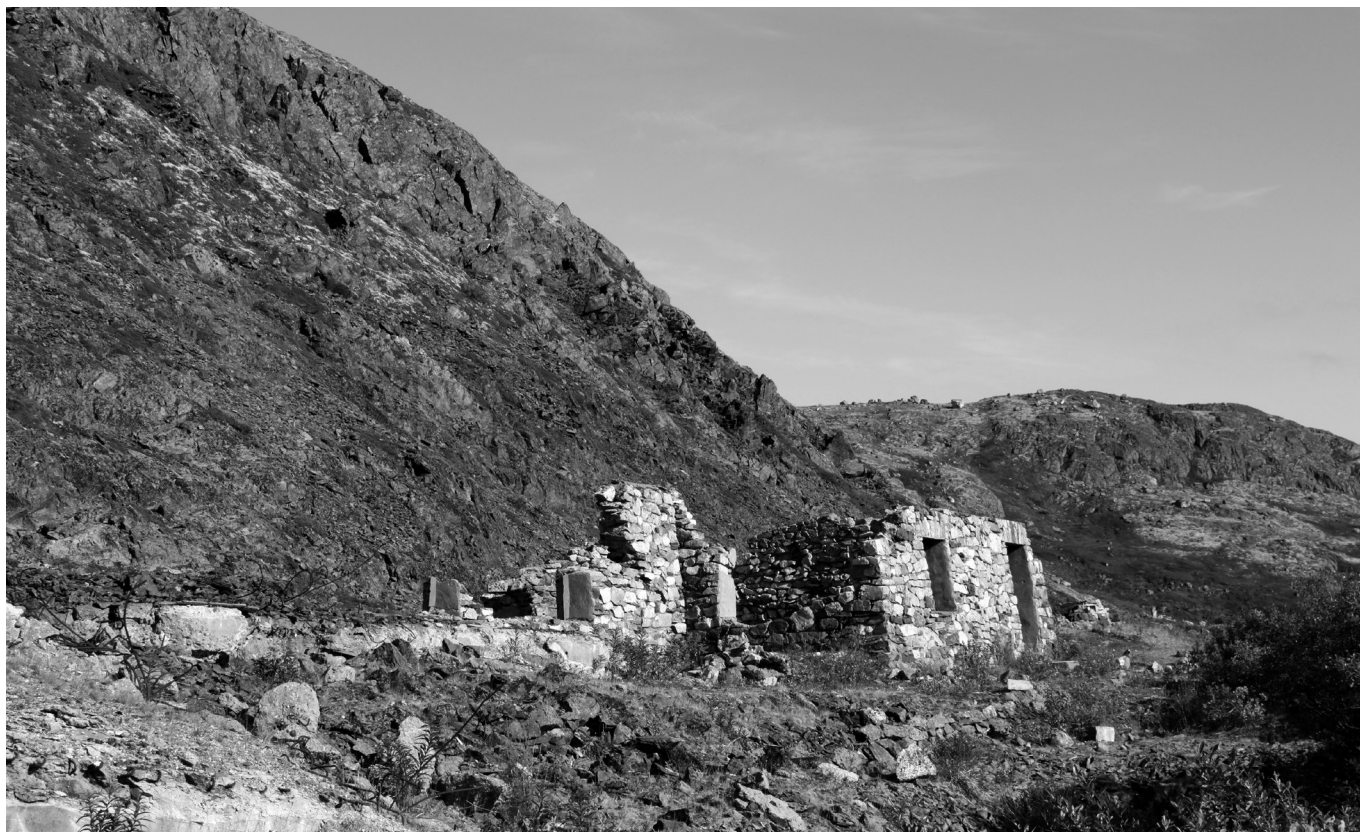
Рис. 2. Современное состояние здания, в котором размещался штаб немецкой группировки на полуострове Средний.
