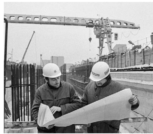
1 февраля 1986 года. Строительство метрополитена в Варшаве в Польской Народной Республике
