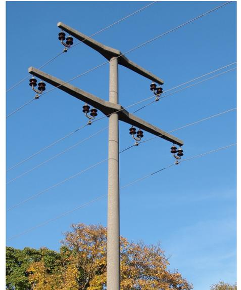
Abbildung 26: 20-kV-Mittelspannungsleitung: **power=minor\_line**, Mast: **power=pole**. An den Way kann außerdem noch: **voltage=20000**; **frequency=50**; **cables=6**; **circuits=2**; **wires=single**. Diese Werte aber bitte nur taggen, wenn du dir sicher bist, dass sie stimmen!
