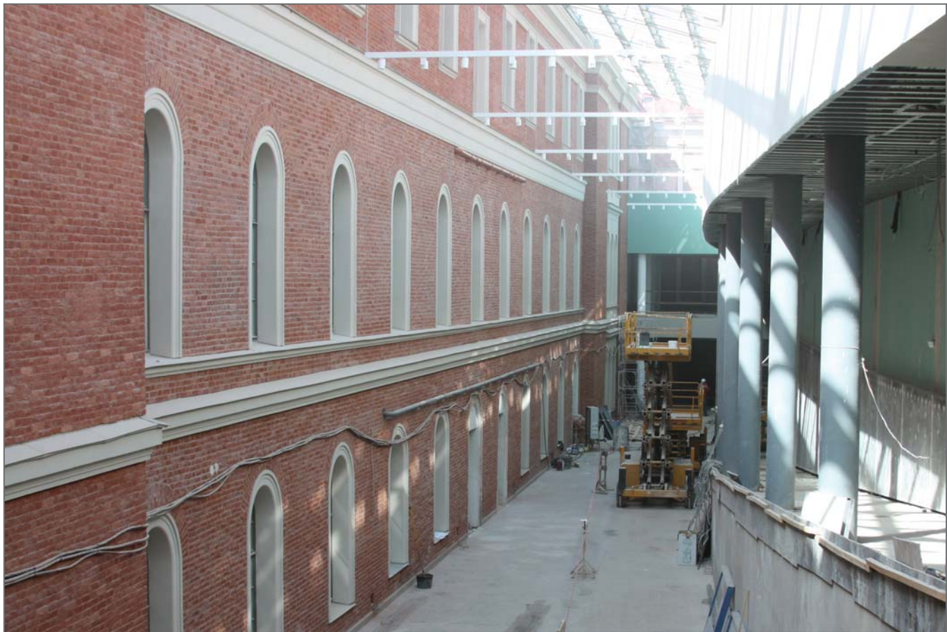
Строительные работы в новом здании музея – Крюковских ( Морских ) казарм
