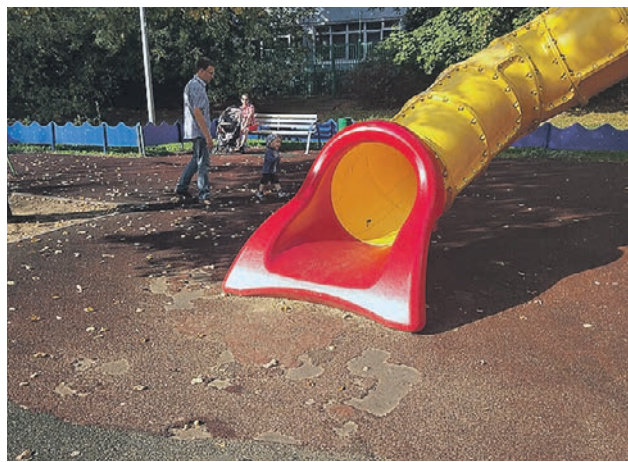
Работы по устранению дыр в резиновом покрытии выполняются оперативно
