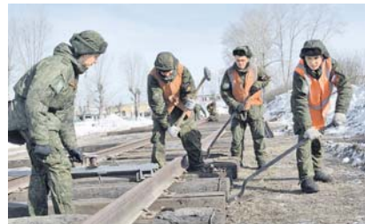
Путьцы-конкурсанты отработывают норматив по сборке звена рельсошпальной решётки.
