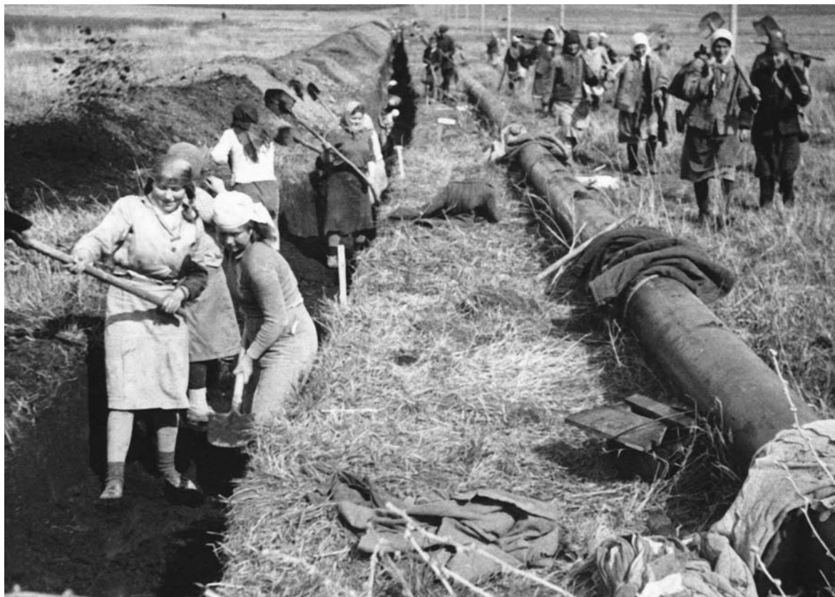
Советские женщины на строительстве газопровода Саратов — Москва
