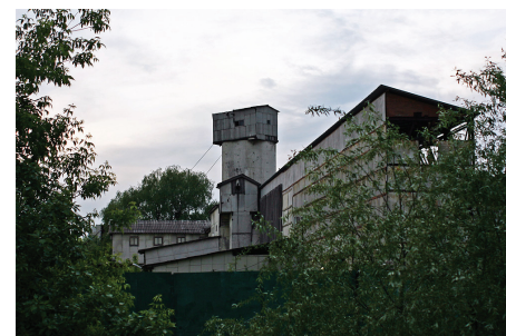
Так, например, может выглядеть вход в подземное сооружение
