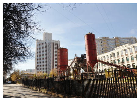
Бетонный завод рядом с РАНХиГС
