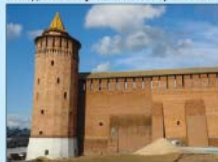
▲ Маринкина башня. Коломна. В разломе стены видна полубутровая конструкция стены: между внешними слоями кирпичной кладки находится забутовка из необработанного камня
