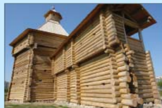
▲ Стены Сумского острога построены террасами. Нижняя часть внешней стены двойная: между двумя рядами брёвен находилась земляная засыпка. Верхняя часть стен (облам) немного нависает над нижней, образуя зазор для обстрела подошвы стены
