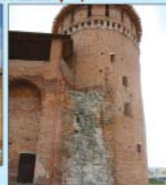
▲ Маринкина башня. Коломна. В разломе стены видна полубутровая конструкция стены: между внешними слоями кирпичной кладки находится забутовка из необработанного камня
