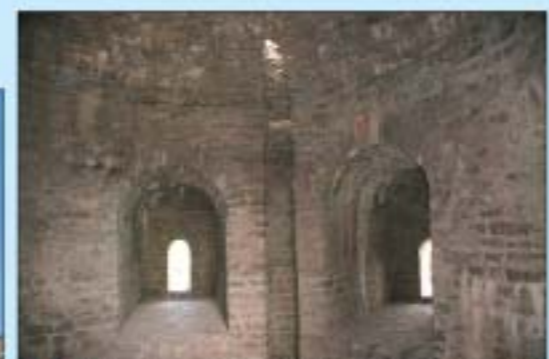
▲ Бойницы с камерами в башне наместника, Иваногород. Между камерами виден дымоотвод
