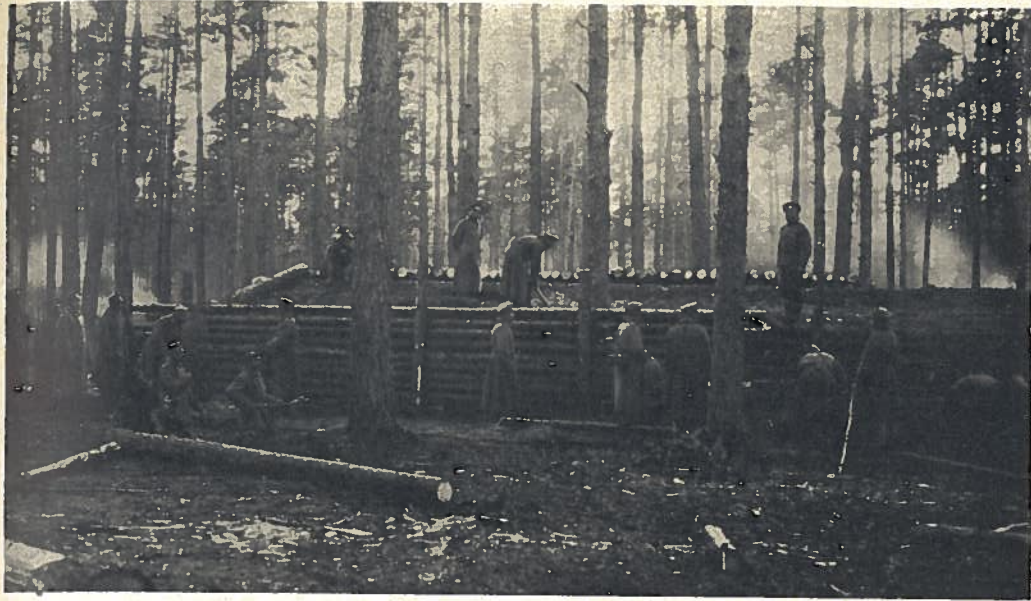
Постройка зимняго блиндажа.
