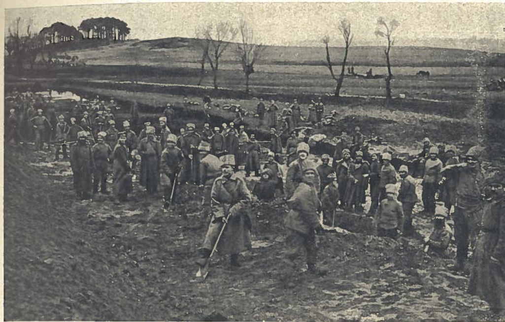
Работа по устройству желѣзной дороги.
