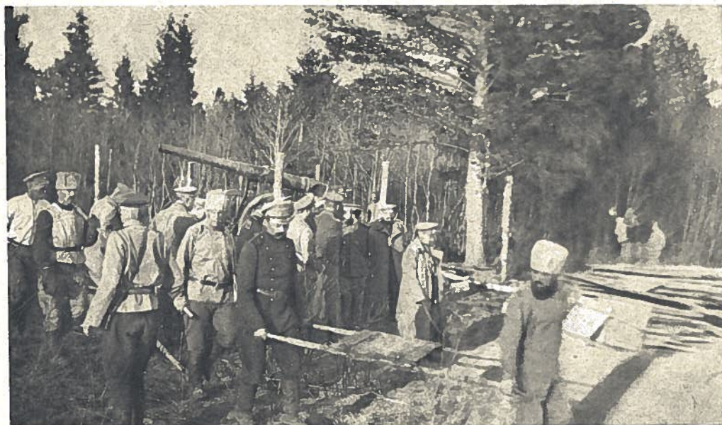
Установка тяжелыхъ орудій на позиціи.
