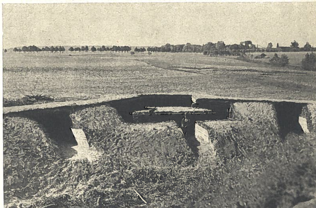
Видъ съ тыла одного изъ окоповъ (горизонтной профили).
