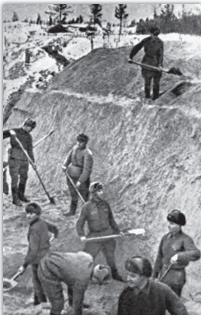
Строительство оборонительных сооружений на Петровской просеке
