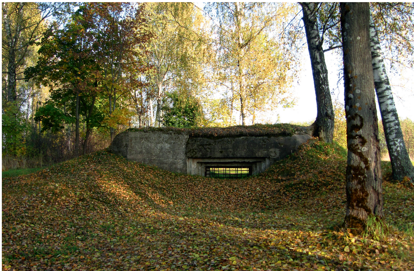
Долговременная огневая точка (ДОТ) Можайской линии обороны. 1941 г.
