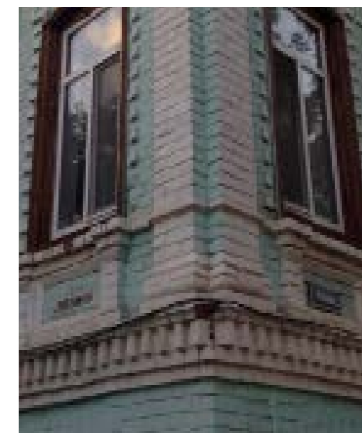
Рис. 124. Домовые таблички размещаются не на углу здания, а в нишах, чтобы не закрывать декор.
