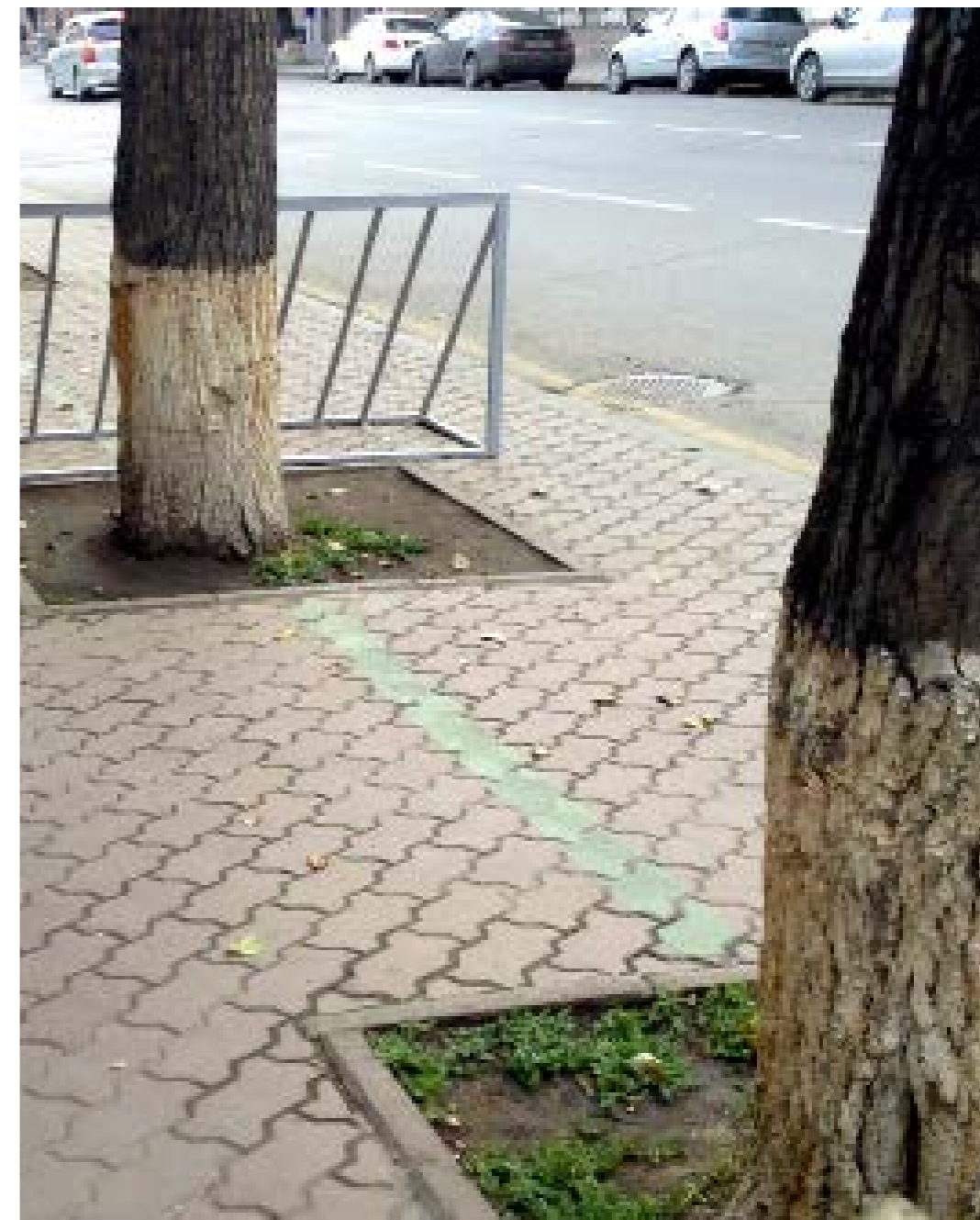
Рис. 146. Линию нужно рисовать так, чтобы она не прерывалась другими объектами. Она всегда должна быть в поле зрения.
