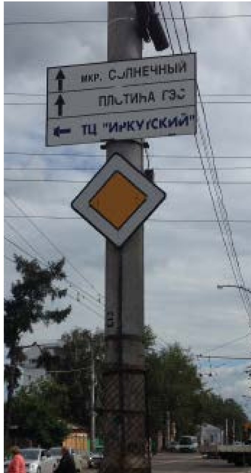
Рис. 314. Текст на табличке сделан аппликацией самоклеящейся плёнкой, поэтому буквы начали деформироваться. Кроме того, в тексте ошибка в сокращении слова «микрорайон».
