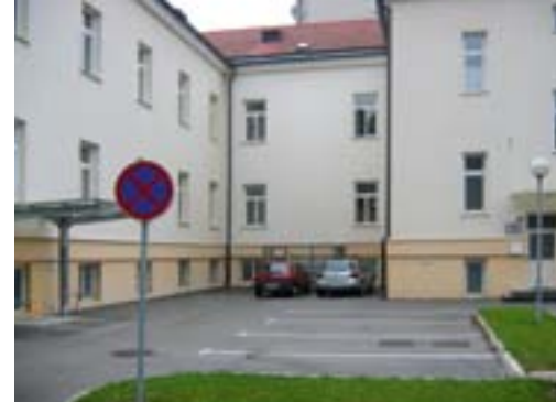
Stavba enote v Škofji Loki
