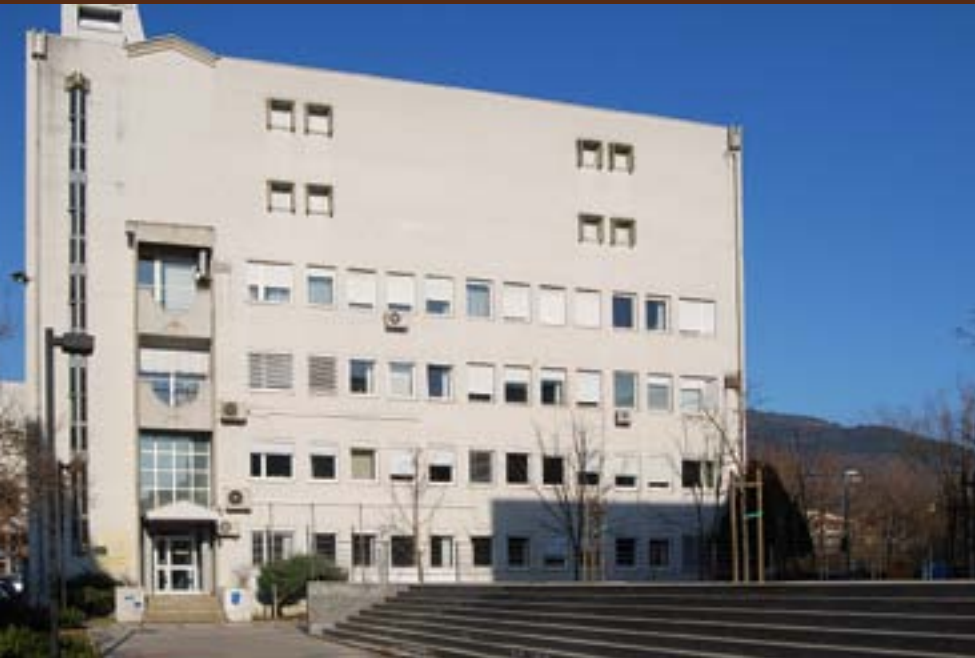
Stavba Pokrajinskega arhiva v Novi Gorici
