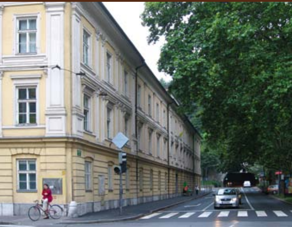
Stavba Nadškofijskega arhiva Ljubljana
