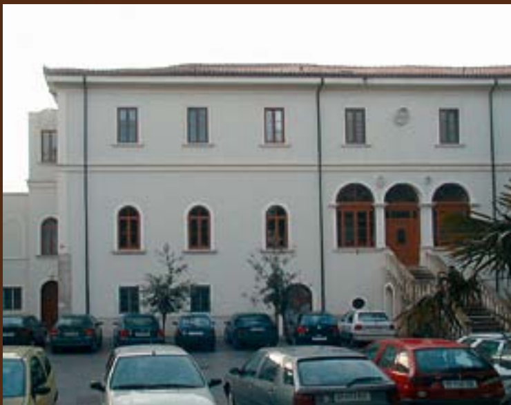
Stavba Škofijskega arhiva Koper
