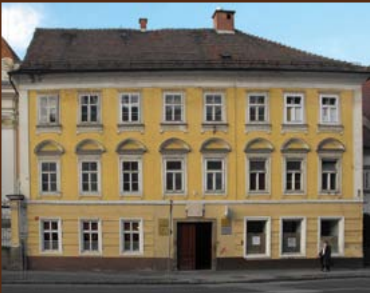
Stavba Nadškofijskega arhiva Maribor
