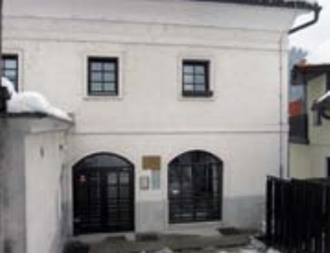
Stavba enote za Gorenjsko Kranj
