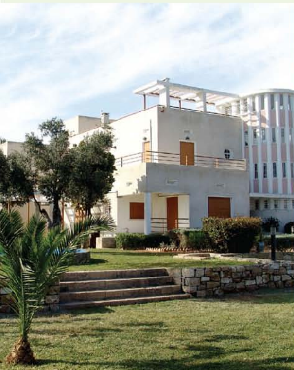
Βελτιωτικά έργα στη Δημοτική Πινακοθήκη και κατασκευή προσβάσεων για άτομα με ειδικές ανάγκες.
