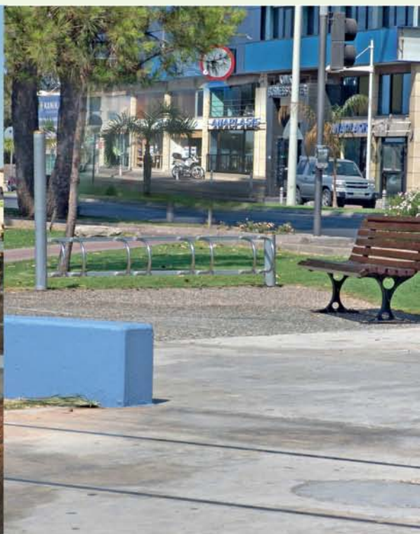
Κατασκευή 6 ποδηλατοστασίων και σήμανση ποδηλατοδρόμων.
