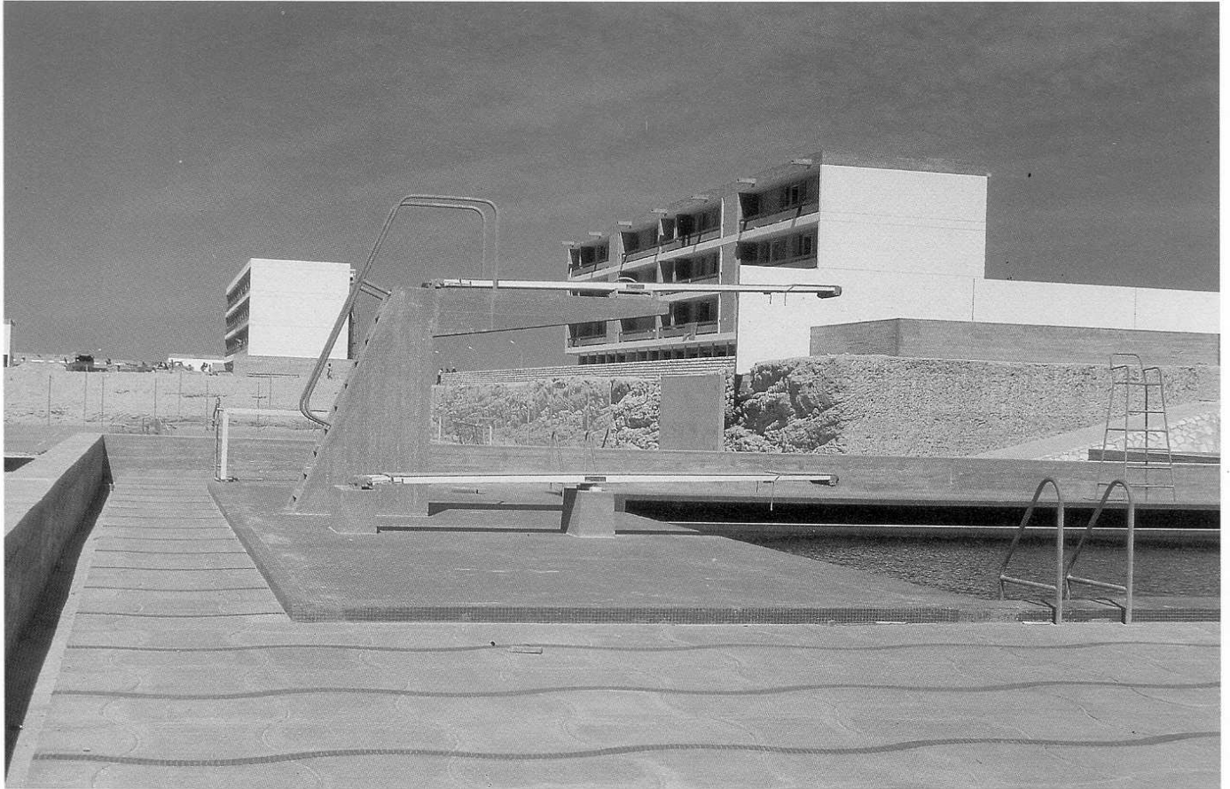
Cansado. Jeux de volumes et de couleurs pour le club, protégé des vents par des murs-écrans et d'où l'on peut descendre vers la mer par une succession de terrasses.
