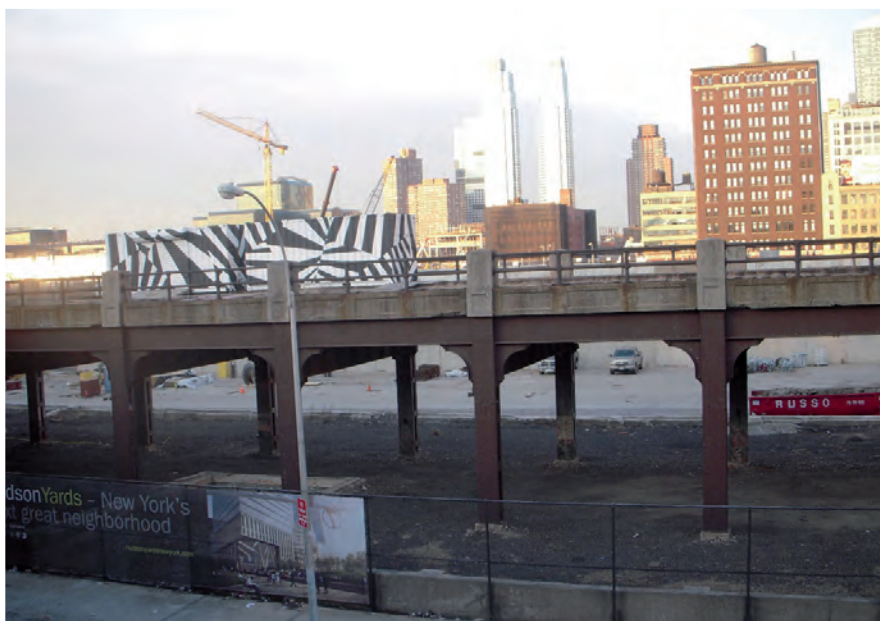
Aménagement de terrains en vue de la construction de gratte-ciels de standing dans l'ancien quartier ouvrier de Hell's Kitchen (Manhattan, New-York)
