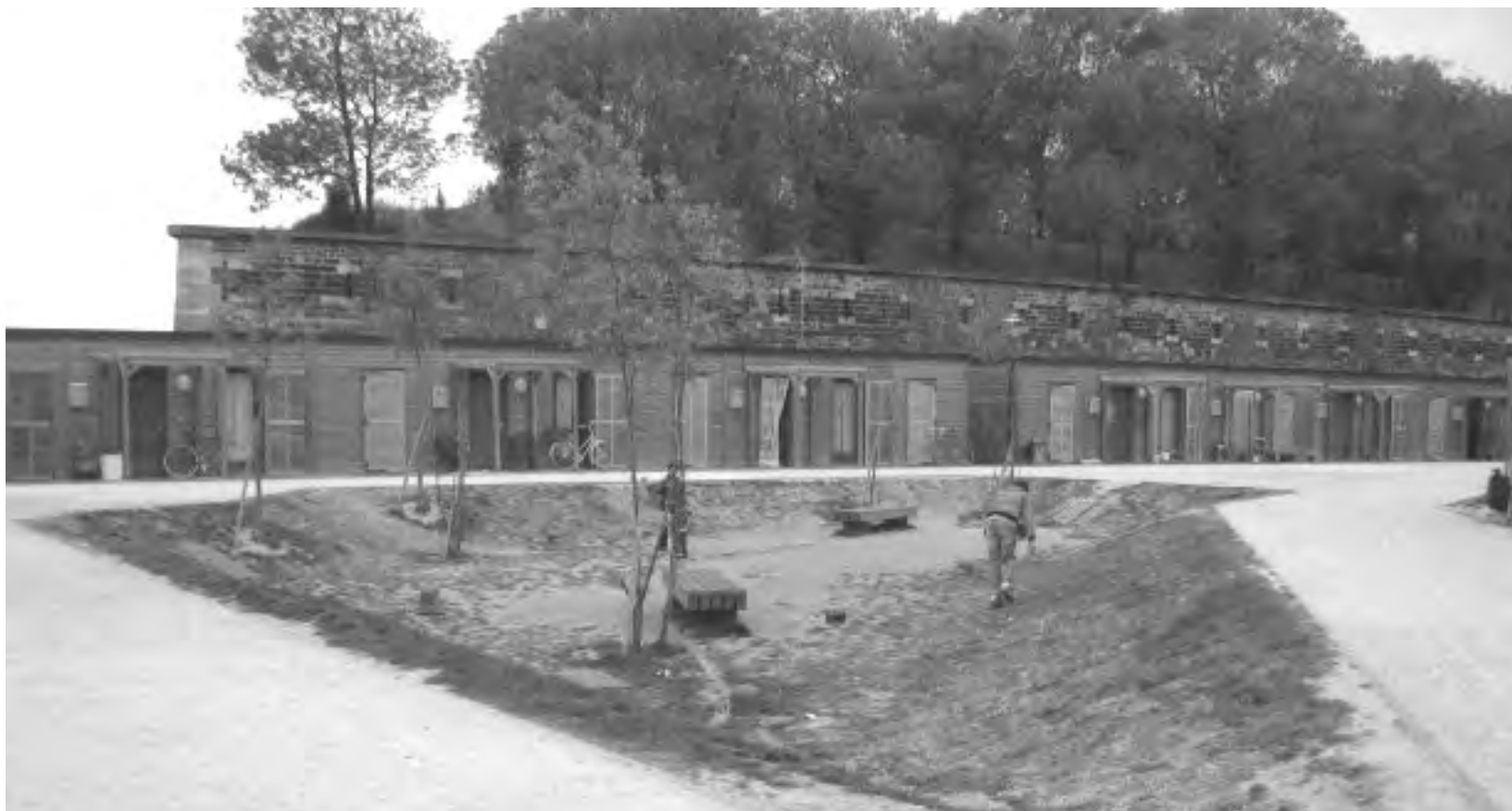
VILLAGE D'INSERTION DE SAINT DENIS. LA « PLACE » DU VILLAGE EST DIRECTEMENT VISIBLE DEPUIS LA LOGE DU GARDIEN. ON DISTINGUE À L'ARRIÈRE PLAN LE MUR QUI ISOLE LE VILLAGE DU TERRAIN MILITAIRE DE FORT DE L'EST.
