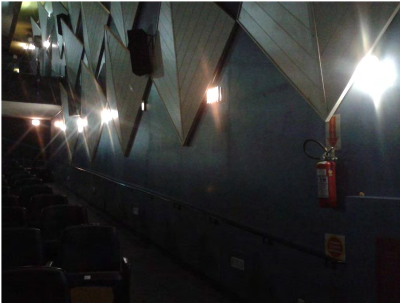
Auditório Garapuvu iluminado pelo sistema de luzes de emergência, incluindo placa indicadora de saída (ao centro)
