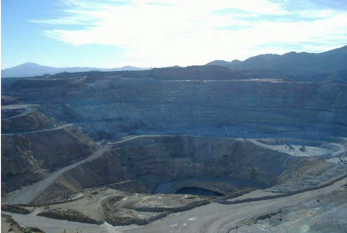
Foto No. 2: Área de excavación y explosión en el Departamento Mina de Operación
