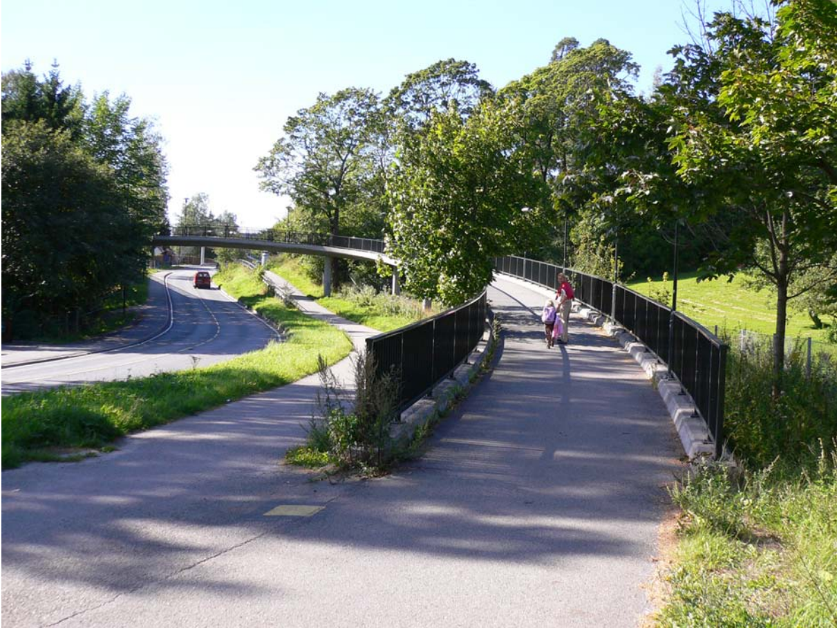
Over: For å hindre trafikkarfarlig kryssing av vegen er det laget en velformet gangbru ved Stabekk skole i Bærum. Lengde og plassering av brua i terrenget gjør at stigning og høydeforskjell ikke er en stor barriere ved kryssing av vegen.
