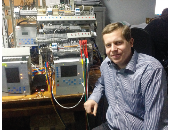
Проведення розширеного технічного курсу по пристроям P3A Relion 600 ПАТ «ДТЕК Дніпрообленерго», 2015р. на фото: Олександр Гончарук, експерт по P3A, ABB Україна
