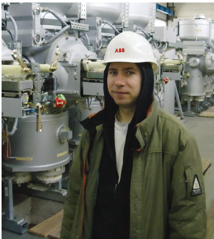
Виконання робіт по налагодженню пристроїв РЗА та системи MicroSCada для КРУЕ 110 кВ, Алчевський металургічний комбінат на фото: Віктор Шехов, інженер РЗА та АСУ ТП, АБВ Україна
