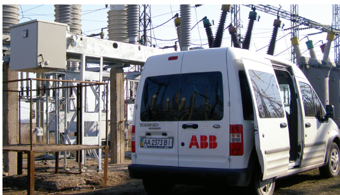
ПС 330 «Новокаховська» Виконання робіт по монтажу вимикачів АBB, LTB170
