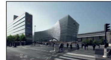
Secteur Austerlitz Transformation en cours
