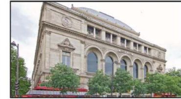
Théâtre de la Ville Rénovation en cours
