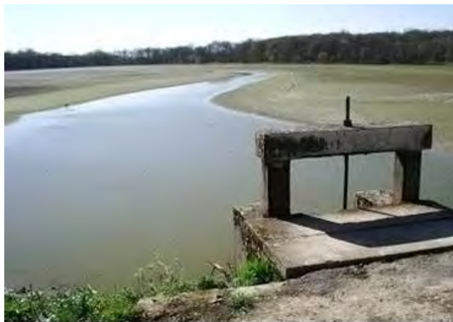
Un étang de la Dombes en période d'assechement, avec son thou et sa pêcherie (au premier plan) ainsi que son bief principal (en arrière-plan), avril 2011 © S. de Carrara
