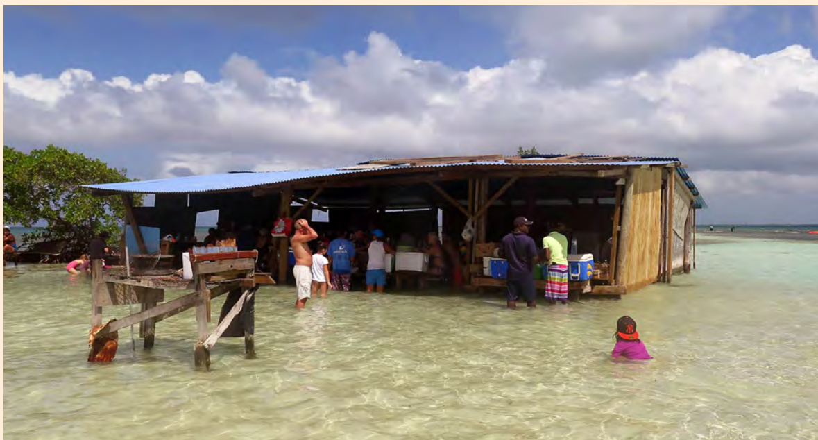
Construction non autorisée sur zone humide : Ilet La Biche Guadeloupe © Alain Pibot - Conservatoire du littoral
