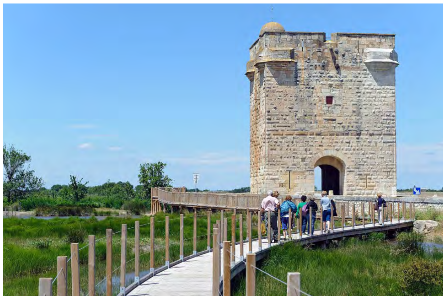
Aménagement des abords de la Tour Carbonnière à Saint Laurent d'Aigouze © Arnaud Bouissou - Terra
