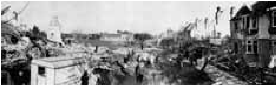
Die verwüstete Staveley Road in Chiswick am Morgen des 9. September 1944 nach dem Einschlag der ersten V2 am Abend zuvor. ©IWM HU66194
