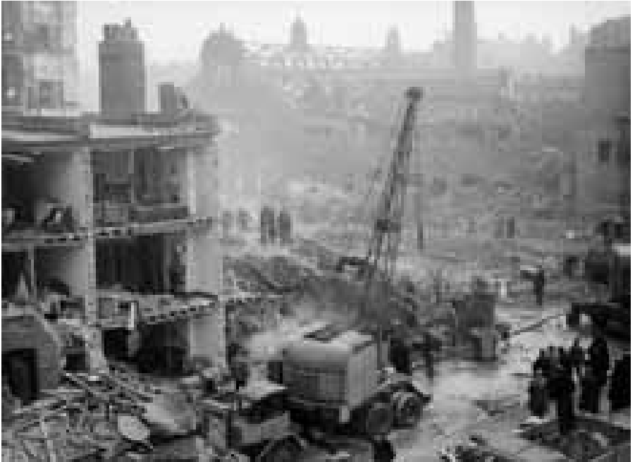
Die verheerenden Auswirkungen des V2-Einschlags am 4. Januar 1944 in Lambeth: Die Stirnwand des vorderen Gebäudes wurde von der Explosion weggerissen, während die fünfstöckige Surrey Lodge dahinter komplett einstürzte. Die schwer beschädigten Lambeth Baths im Hintergrund befinden sich auf der anderen Seite der Lambeth Road. © Lambeth Archives 00201
