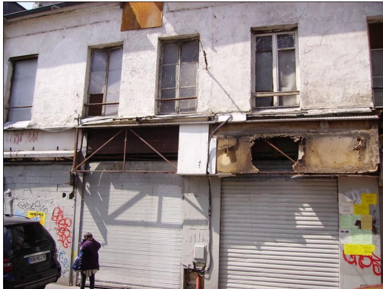
Photographie 4 : ancien bâtiment squatté rue Ramponneau (dispositifs anti-squats visibles : murages, stores, fenêtres bloquées)
