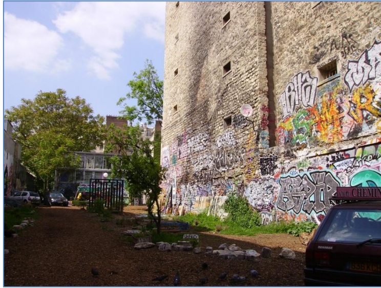
Photographie 3 : entrée de la Forge, 23-25 rue Ramponneau, 75020
