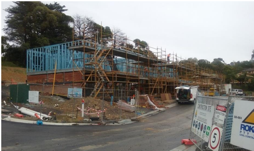
Mingarra construction site
