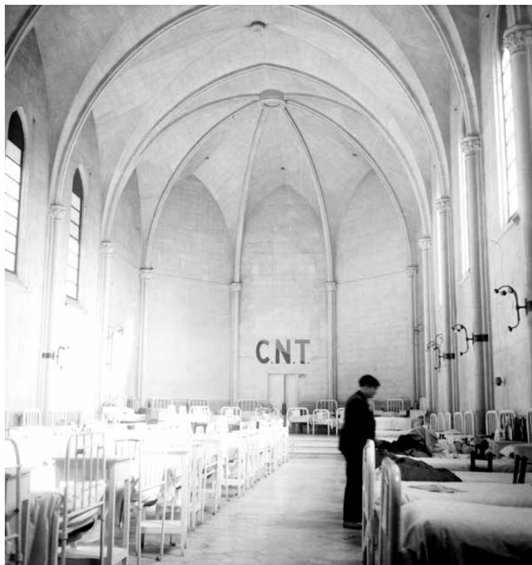
◀ “Construyendo un mundo nuevo. Revolución”. Iglesia habilitada en pueblo colectivizado. 1937.
