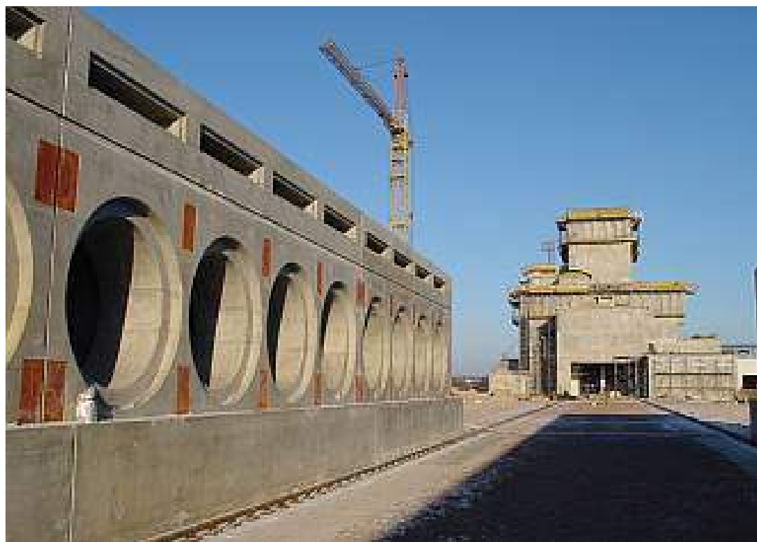
Рис. 5.34. Бетонные модули хранения ХОЯТ-2
