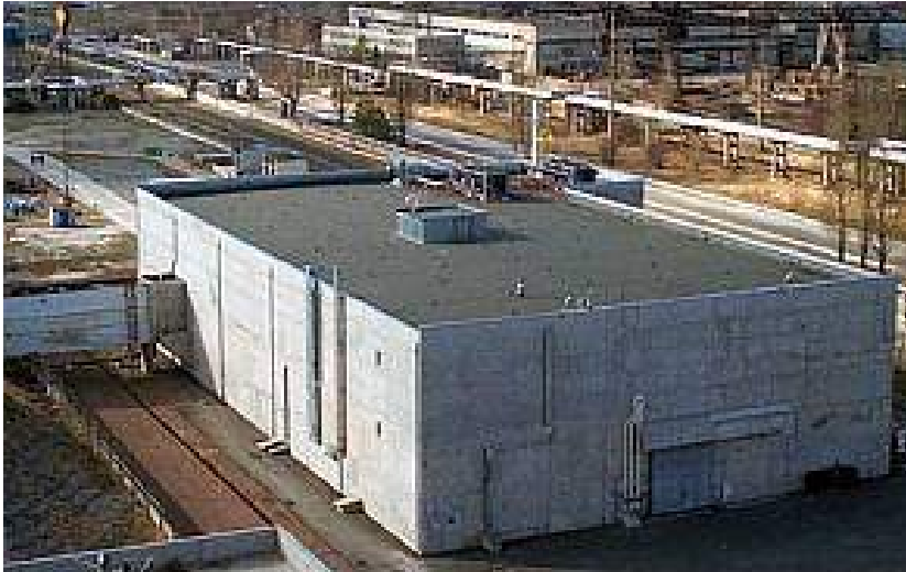
Рис. 5.29. Завод по переработке жидких радиоактивных отходов.
