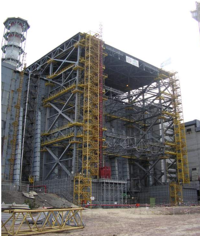
Рис. 5.17. Стабилизация западного фрагмента ОУ.
