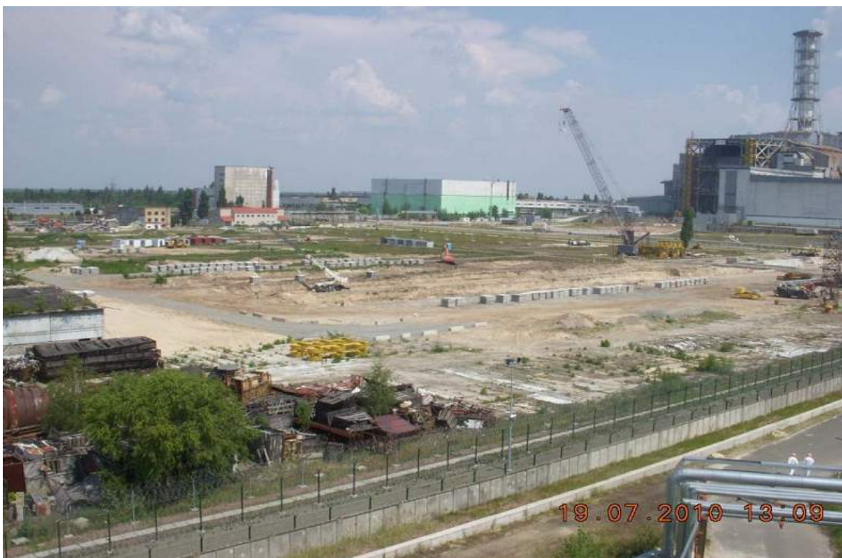
Рис. 5.21. Проведение работ по подготовке площадки строительства НБК.
