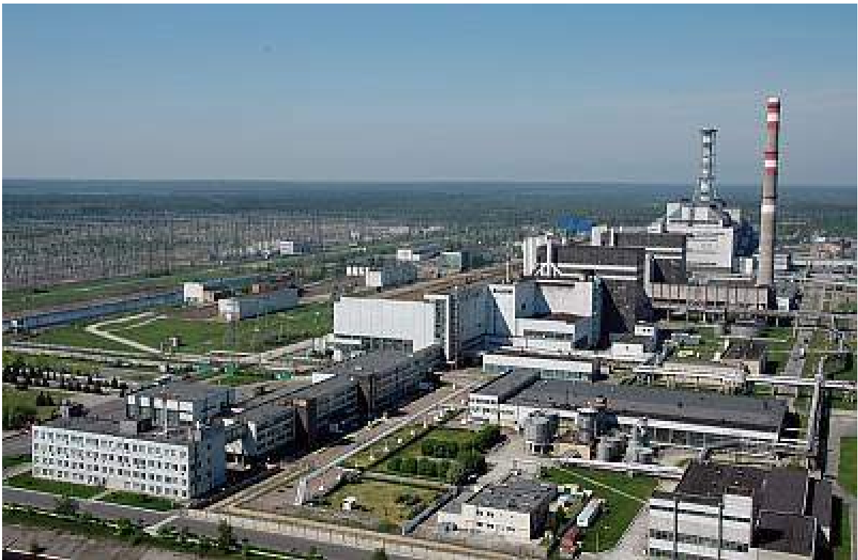
Рис. 5.27. Промышленная площадка Чернобыльской АЭС.
