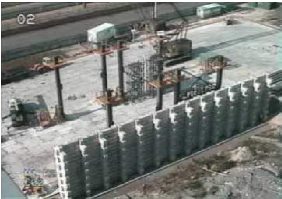
Рис. 5.19. Защитная бетонная стена.
