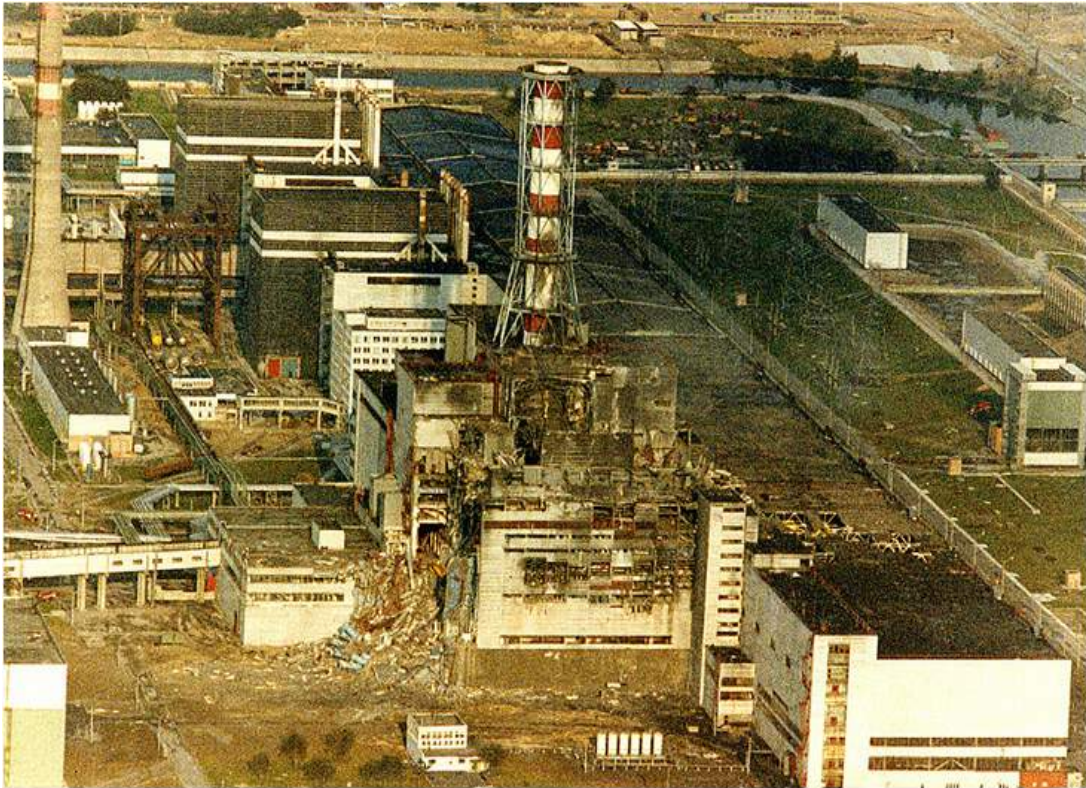
Рис. 1.2. Разрушенный 4-й энергоблок ЧАЭС.
