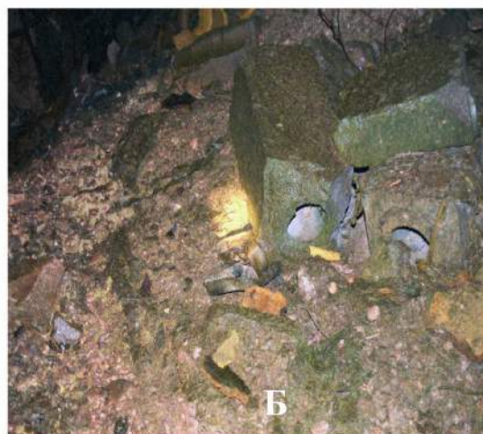
Рис. 5.11. Распыление пылеподавляющих растворов (А) и защитное полимерное покрытие (Б) фрагментов в подкровельном пространстве ОУ.
