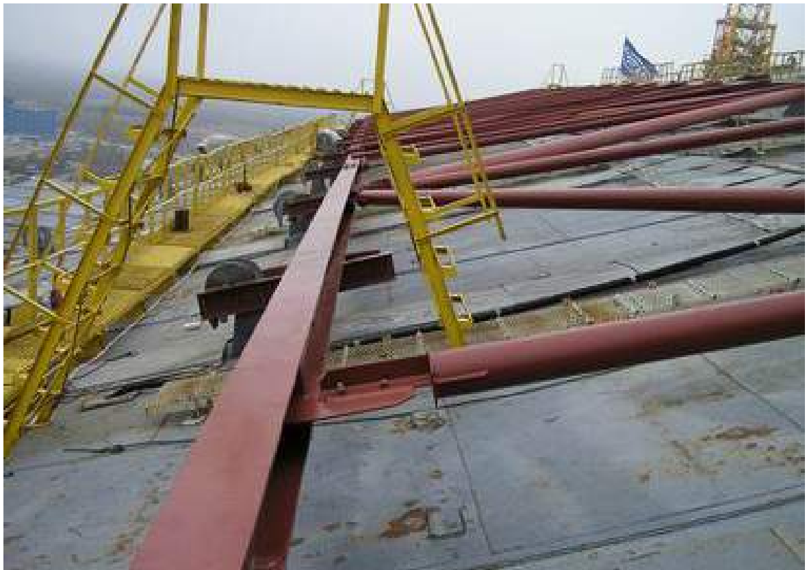
Рис. 5.18. Стабилизация южной части покрытия.
