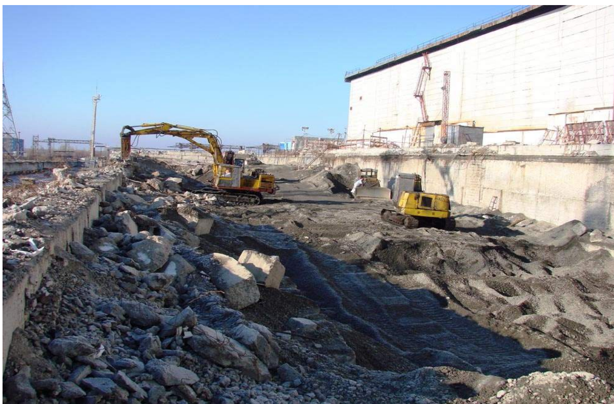
Рис. 5.20. Разборка бермы пионерной стены.
