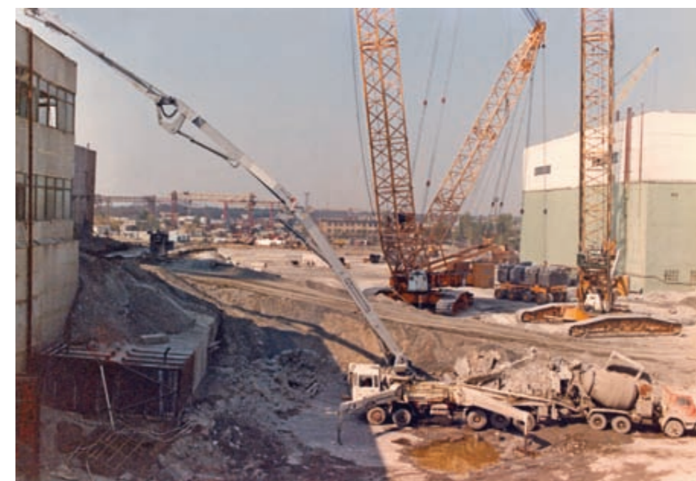
Заливка бетона при строительстве саркофага
